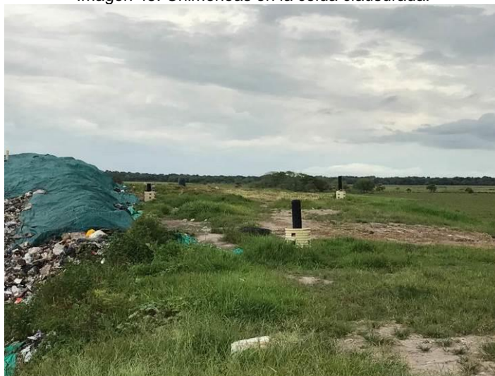
Imagen 45. Chimeneas en la celda clausurada.
