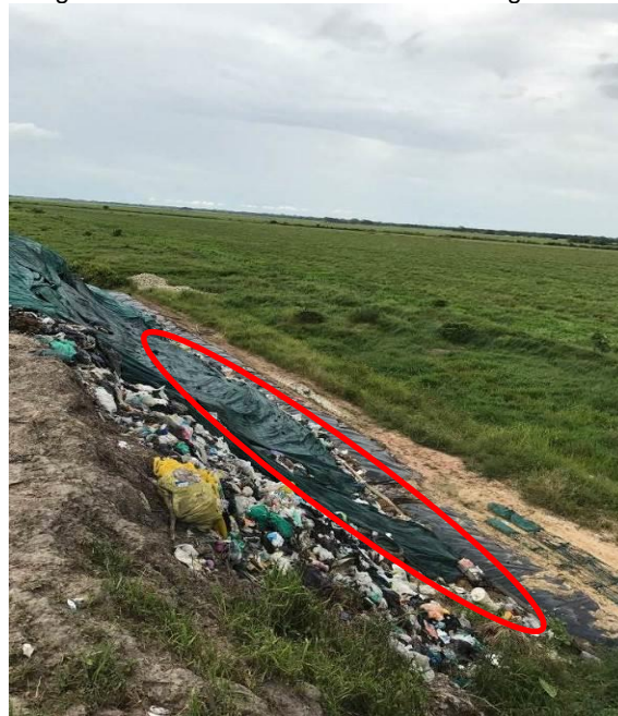
Imagen 43. Celda 2B sin canalización de agua lluvia.
