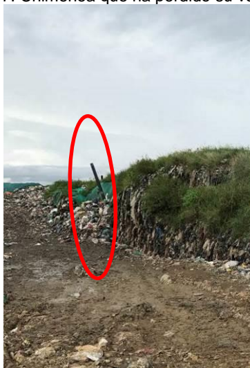
Imagen 47. Chimenea que ha perdido su verticalidad.
