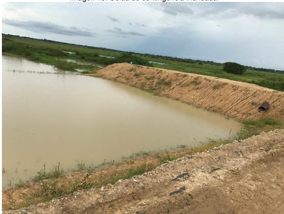
Imagen 49. Celda de contingencia inundada.
