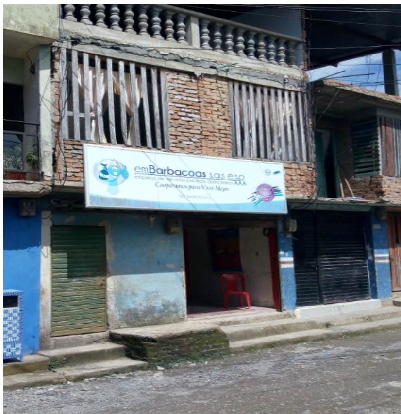
Imagen 7. Sede actual del prestador
