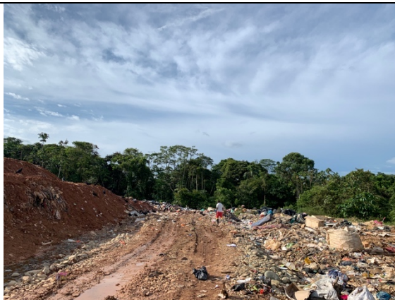
Registro fotográfico – vías internas sin canales y residuos expuestos.
