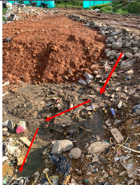
Registro fotográfico – Conducción de líquidos por canales irregulares.
