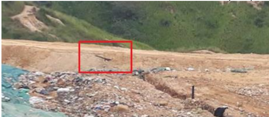
Pérdida de posición vertical chimenea celda 4 cárcava 2
