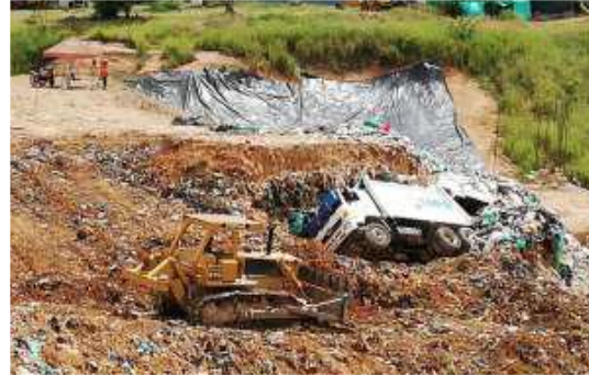
Labores de extracción de camiones recolectores
