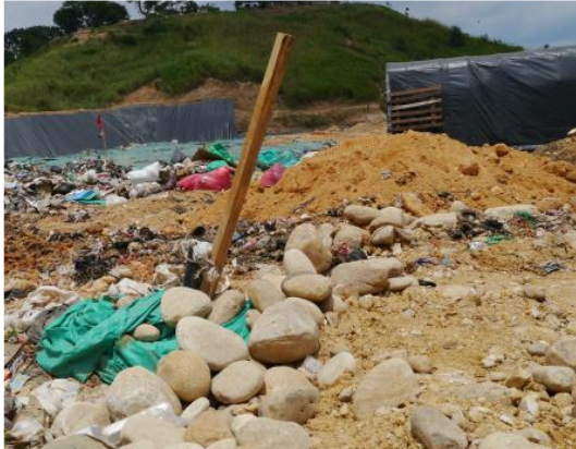
Chimenea que ha perdido su posición vertical
