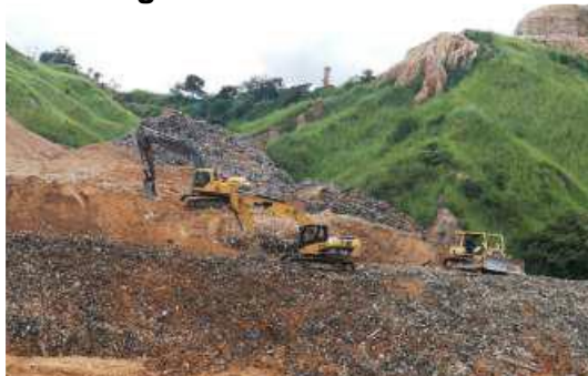
Conformación de terrazas
