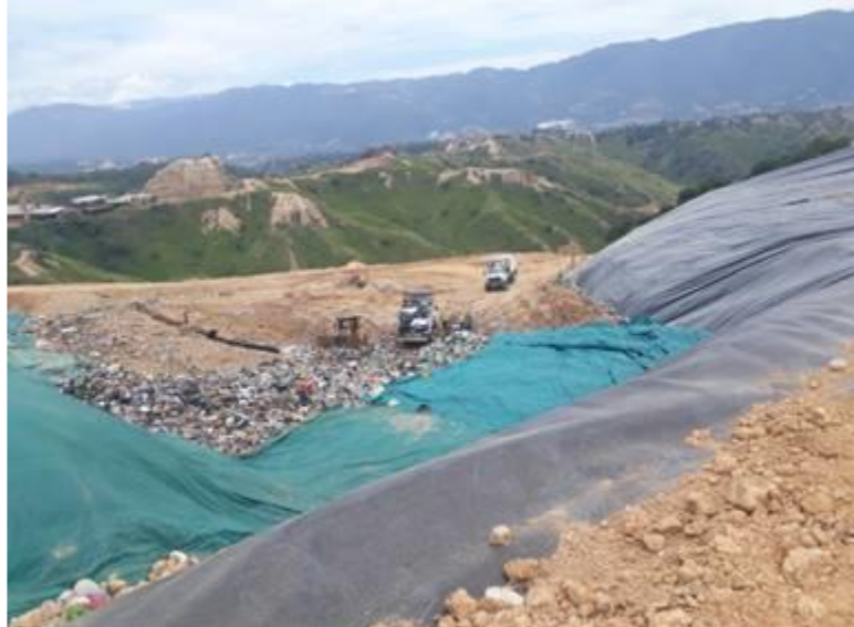
Imagen 23. Frente de trabajo relleno sanitario El Carrasco, celda 4 cárcava 2
