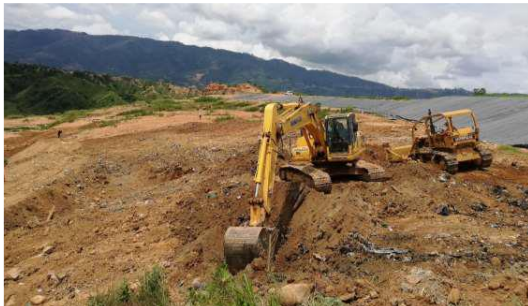
Adecuación del patio
