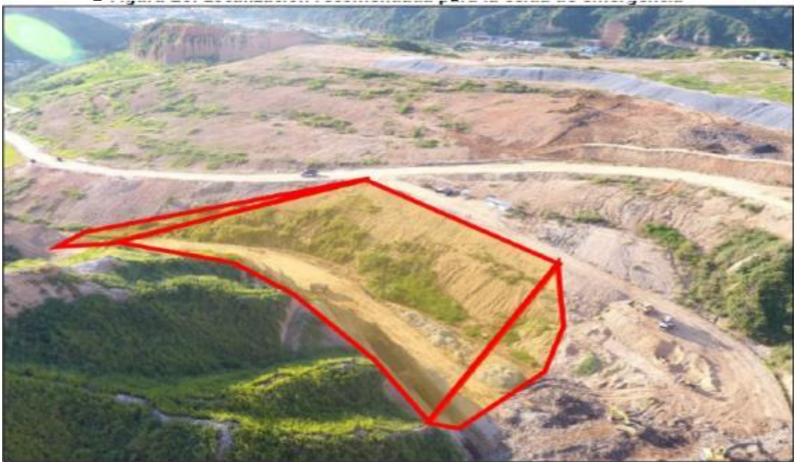
Imagen 48. Localización Celda de Emergencia, en la Celda 4 Fase 3.
