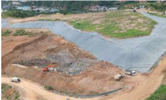
Vista general del patio de descargue
