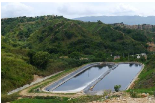
Pondajes de almacenamiento de lixiviados
