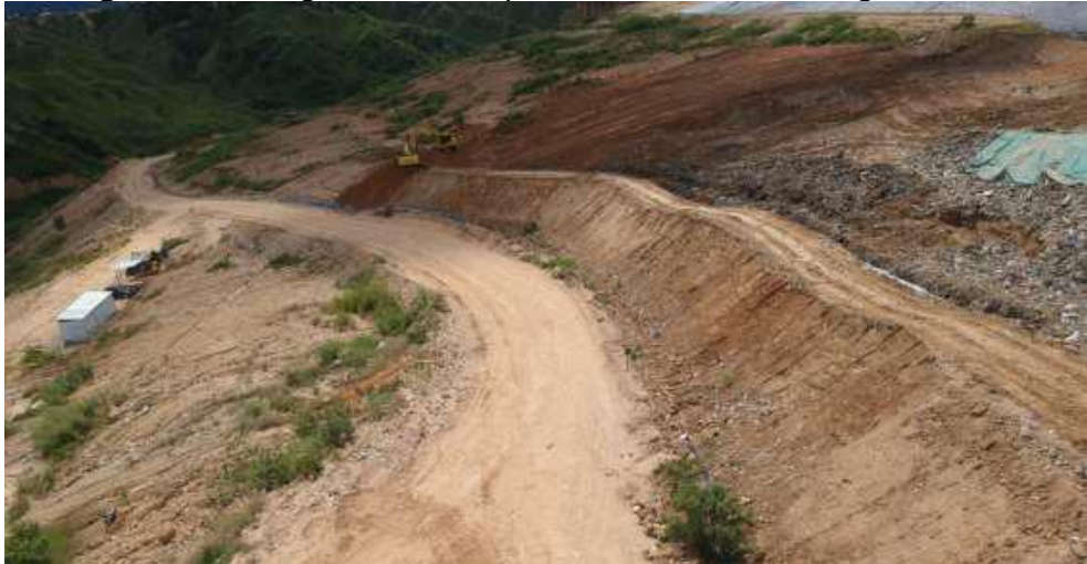
Imagen 30. Vista general del dique de la celda 1 - contingencia
