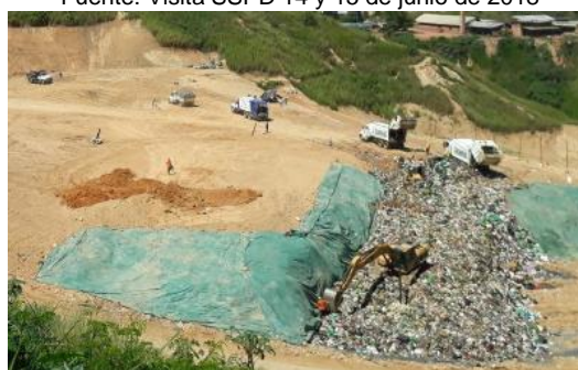
Residuos descubiertos solo en el frente de trabajo Fuente: Visita SSPD 25 de julio de 2017
