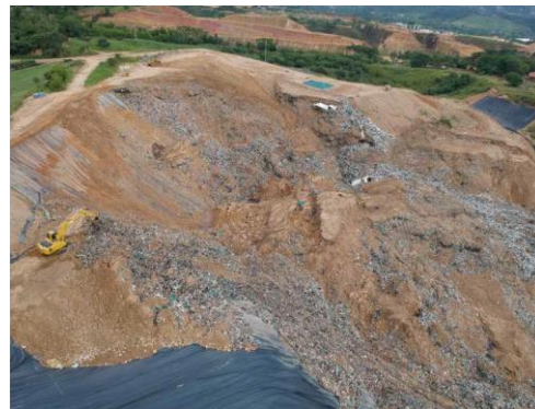
Celda 4 cárcava 2 el día del incidente
