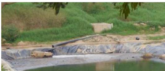
Tubería de descarga vaso activo
