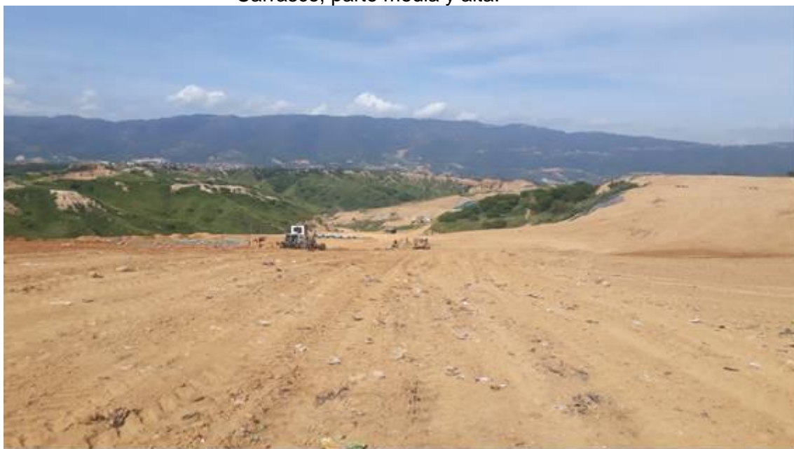
Imagen 38. Alivio de pendientes en la Celda 4 Fase 2 Relleno Sanitario El Carrasco, parte media y alta.
