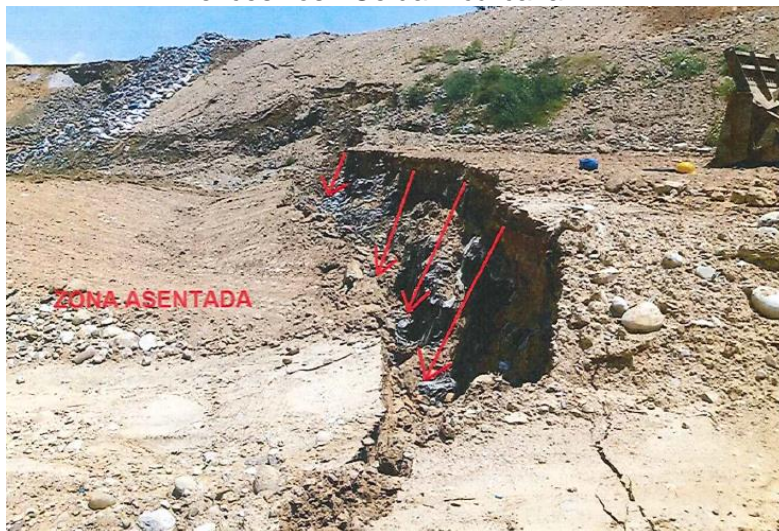
Imagen 28. Zona contigua a la superficie de falla con presencia de asentamientos excesivos– Celda 4 cárcava 2.
