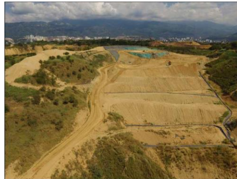
Celda 4 cárcava 2 antes del incidente
