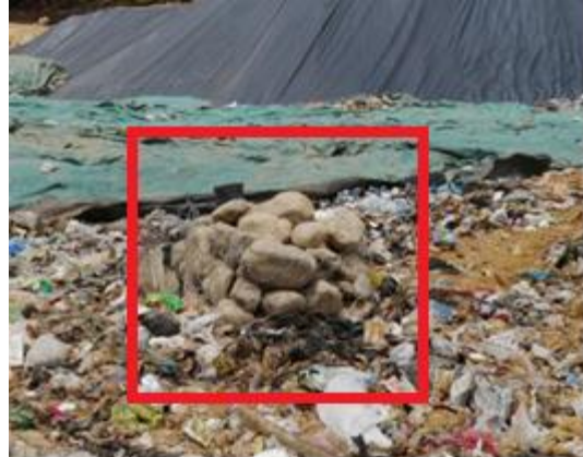
Chimenea a la altura del gavión
