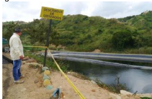
Zona de descarga de lixiviados junto a los pondajes de lixiviados
