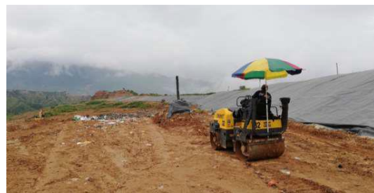
Compactación del terreno
