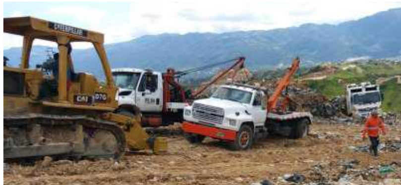
Extracción de vehículos compactadores
