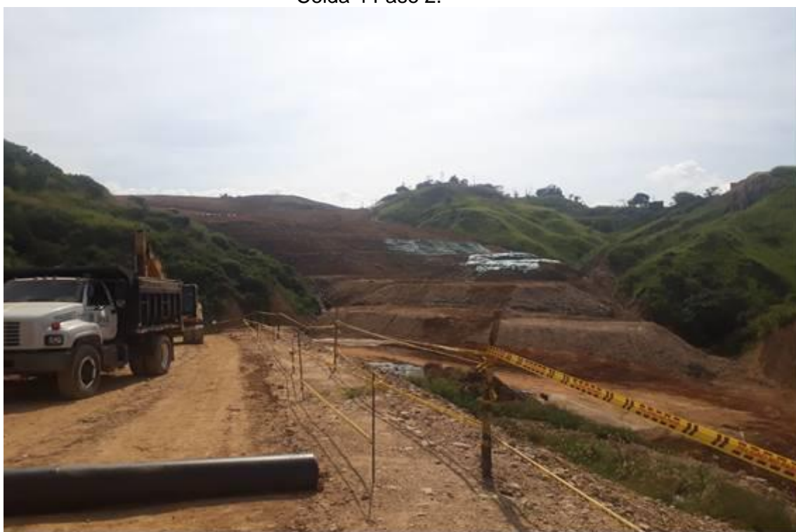
Imagen 39. Alivio de pendientes y re conformación de residuos en la parte baja Celda 4 Fase 2.
