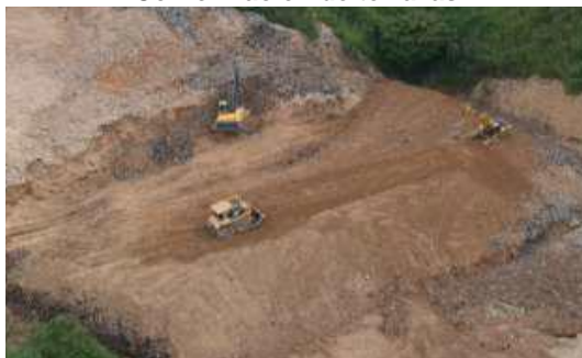
Cobertura con material de excavación
