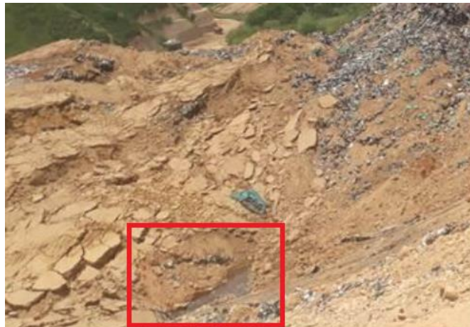
Acumulación agua lluvia en la masa de residuos desplazada el 03 de octubre de 2018.
