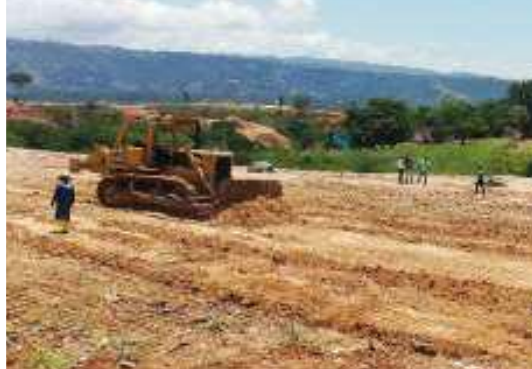
Estabilización parte alta de la celda desplazada
