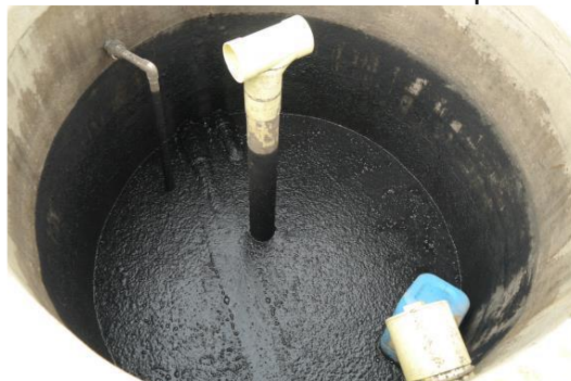
Imagen 54. Pozo de almacenamiento de lixiviado proveniente de pondajes
