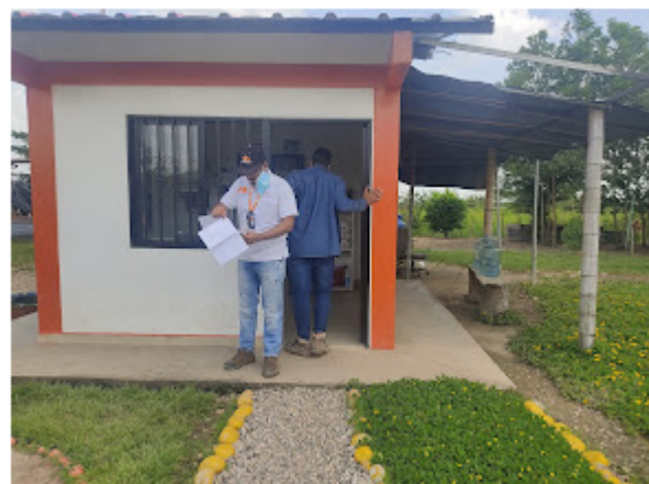
Caseta de pesaje
