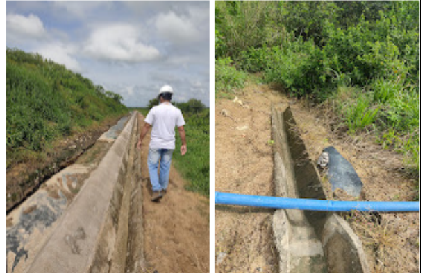
Cuneta de aguas lluvia
