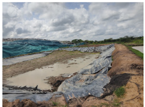
Celda 4 B con empozamiento
