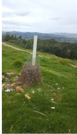
Figura. Chimenea de biogas
