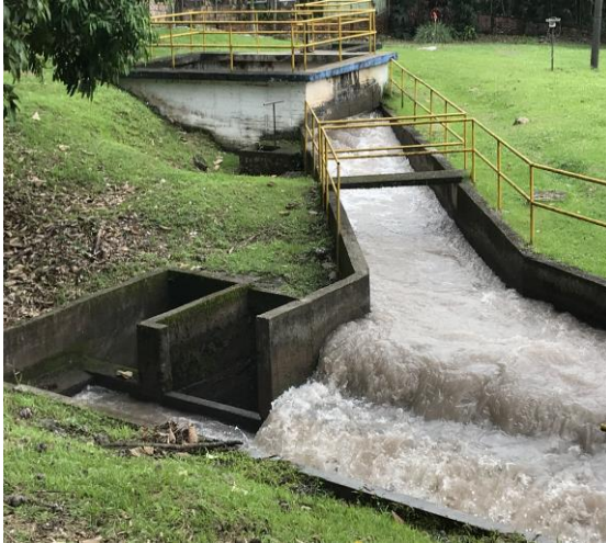
Canal de entrada a la PTAP
