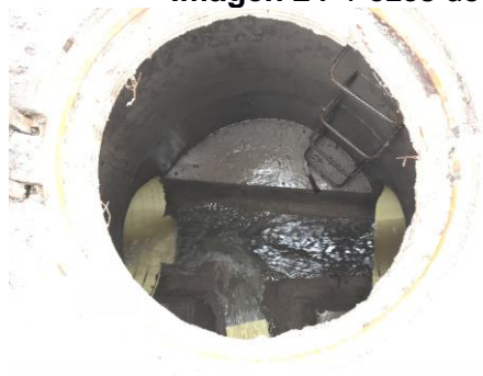
Imagen 24 Pozos de inspección verificados durante la visita
