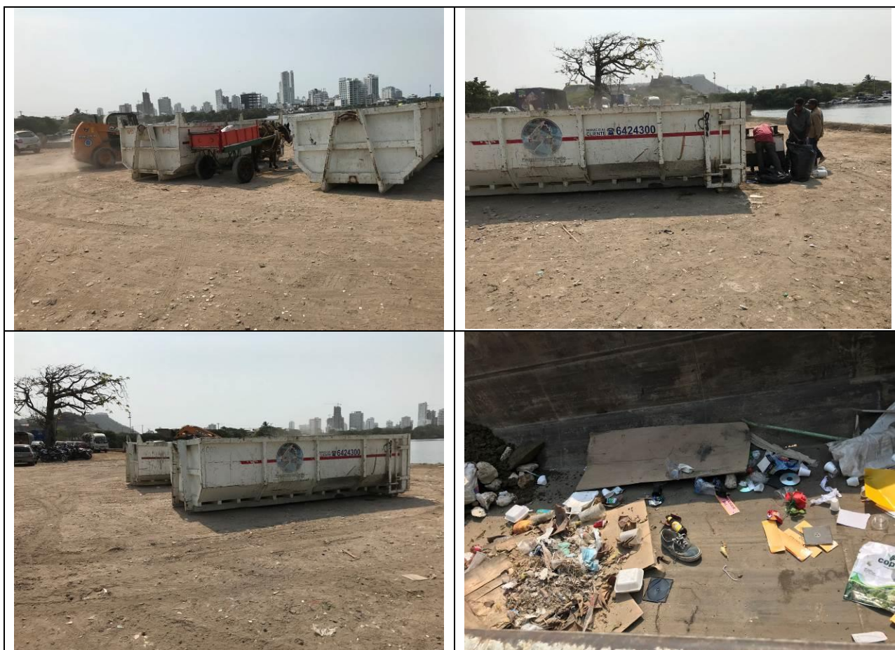
Imagen 15. Sitio denominado "Punto crítico puente caído" Barrio Getzemaní
