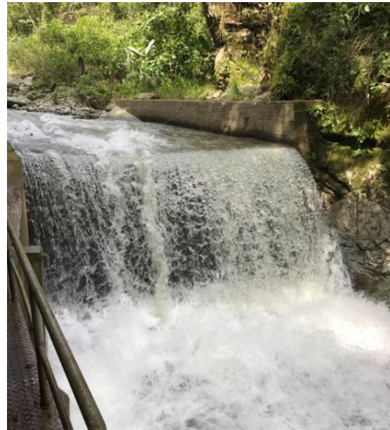
(b) Río Santo Domingo después de la captación de agua
