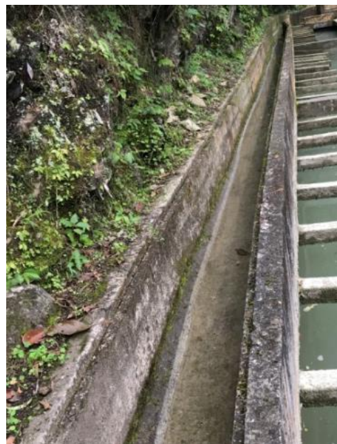
b) By-pass del sedimentador
