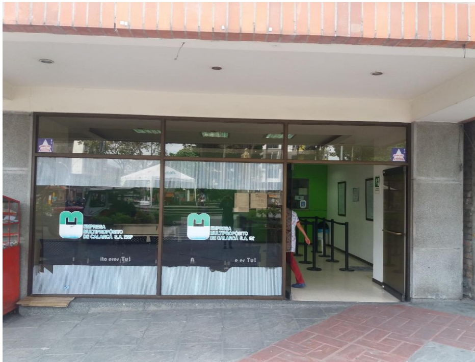
Figura 80. Fachada de Oficina de PQR de Calarcá, Quindío - Empresa Multipropósito de Calarcá S.A.S E.S.P.
