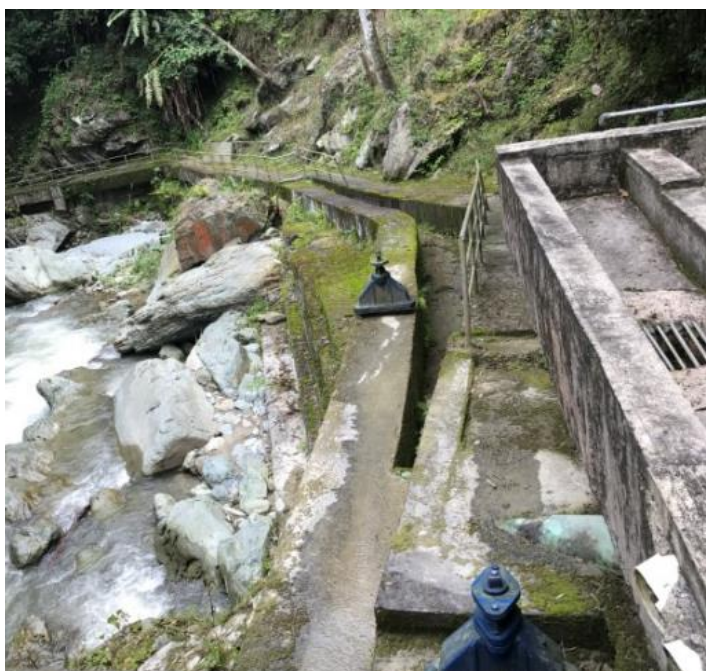
(b) Inicio conducción aguas abajo del sedimentador
