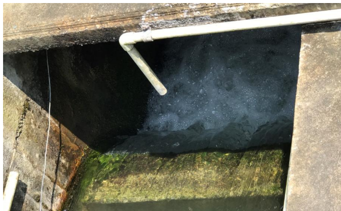
Figura 26. Dosificación del Coagulante PAC por medio de una flauta – PTAP Calarcá, Quindío
