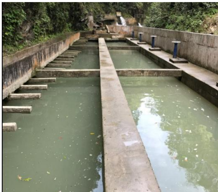
a) Módulos del sedimentador
