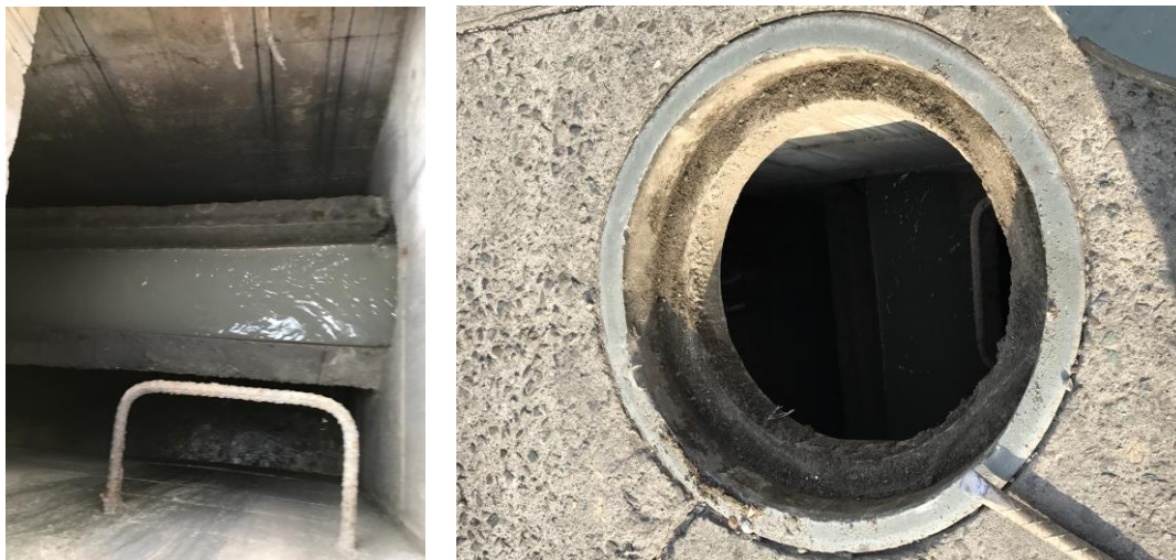
Figura 54. Estructura de Alivio en el Municipio de Calarcá, Quindío.
