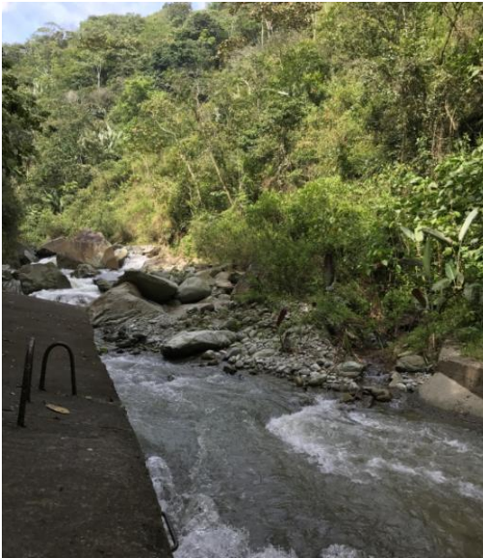
(a) Sección del Río Santo Domingo en el punto de captación
