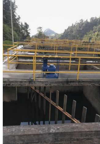
Imagen 17 Floculadores mecánicos
