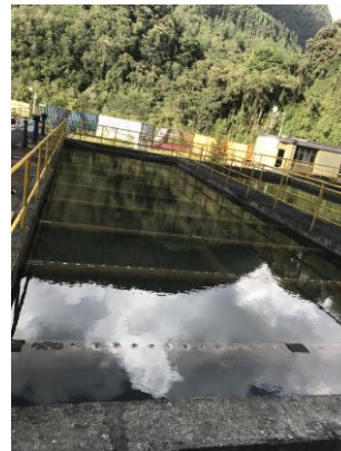
Imagen 19 Sedimentadores
