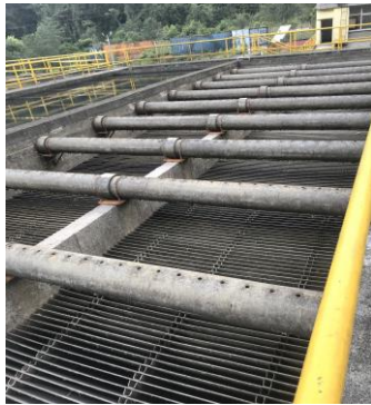
Imagen 18 Sedimentadores en mantenimiento
