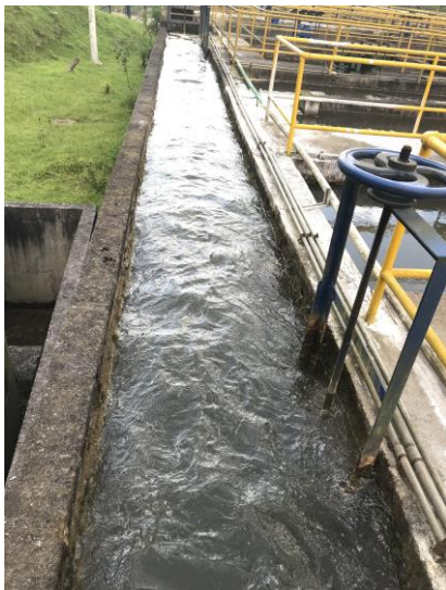
Imagen 24 Canal de repartición a los floculadores
