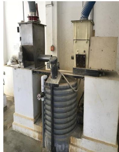
Dosificador del coagulante
