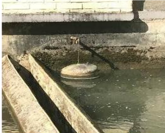
Imagen 15 Algas en las paredes de los filtros
