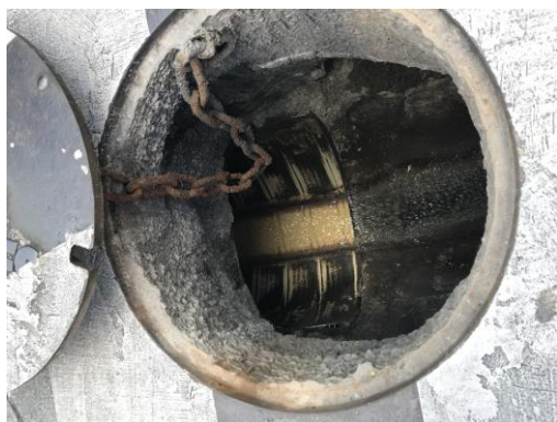
Imagen 38 Pozo de inspección Calle 67 Carrera 10
