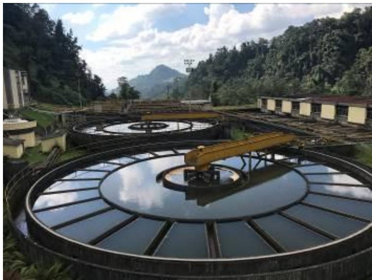
Imagen 13 Modulo Floculación – Sedimentación
