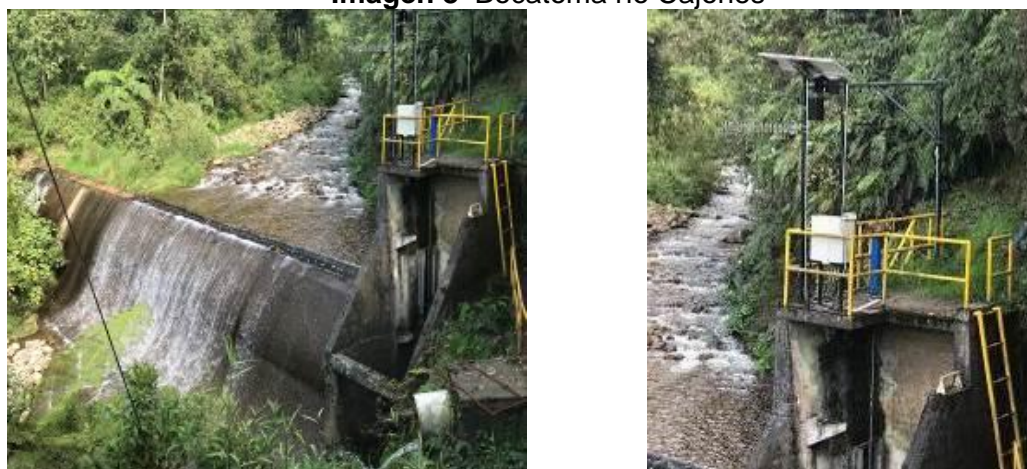
Imagen 8 Bocatoma río Cajones
