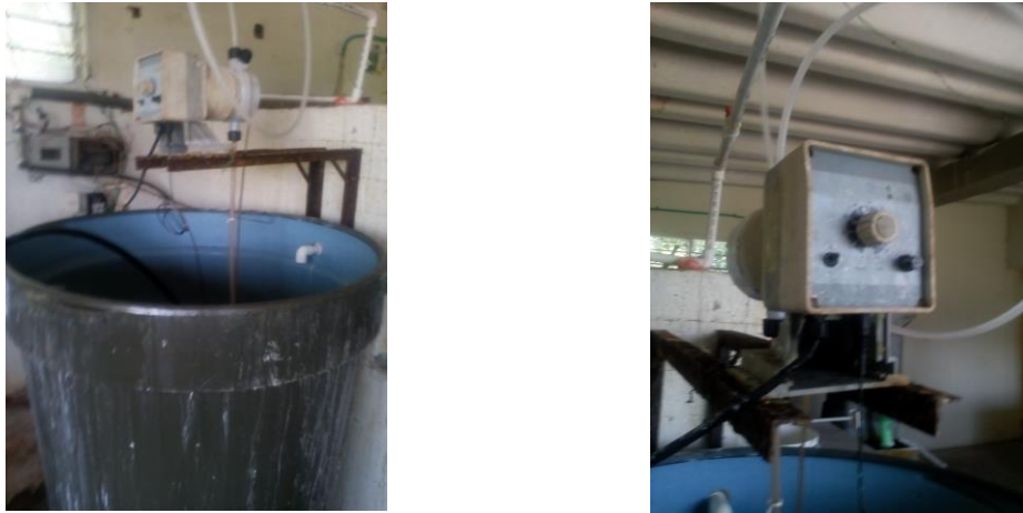
Figura 26 Dosificador del Coagulante
