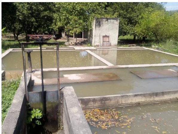
Figura 20 Presedimentador
