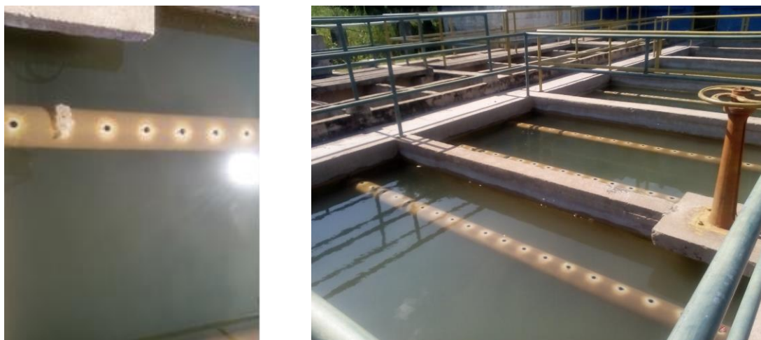
Figura 23 Sedimentadores
