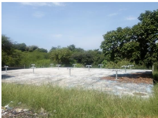
Figura 27 Tanques de almacenamiento PTAP
