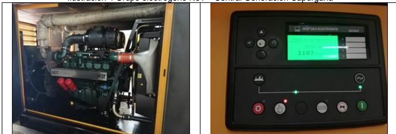
Planta No1 Grupo Electrónico DOOSAN 640 kW Capurganá - Acandí (Operativa)
