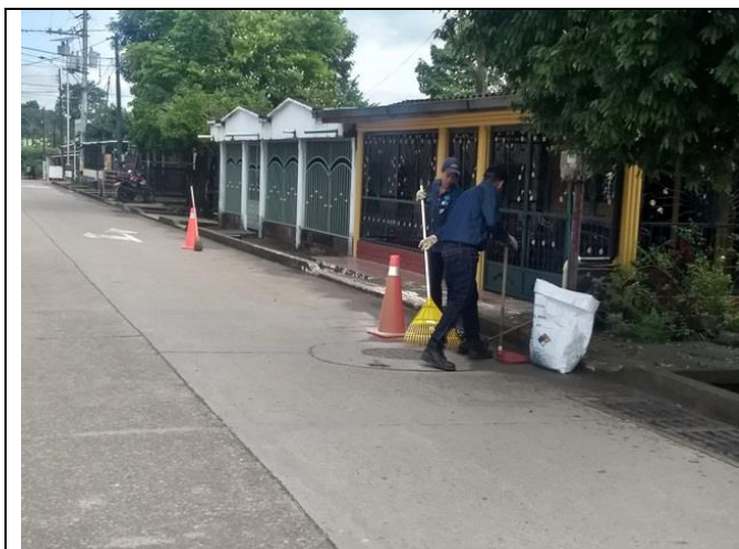
Imagen 91. Verificación actividad de barrido en vía pavimentada
