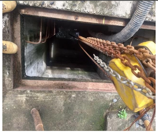
Imagen 61. Instalación bomba de succión para recolección de aguas residuales
