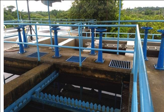
Imagen 27. Módulos de floculación y sedimentación PTAP municipal
