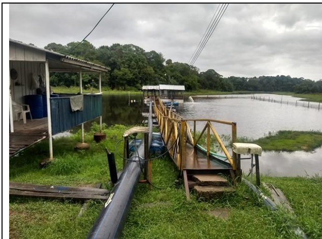
Imagen 17. Aducción Tubería 10"
