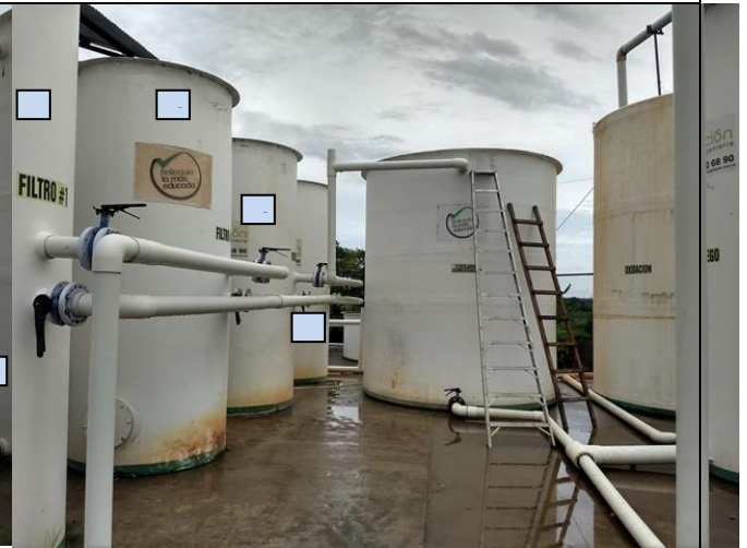
Imagen 24. Cuatro Módulos de filtración PTAP veredal
