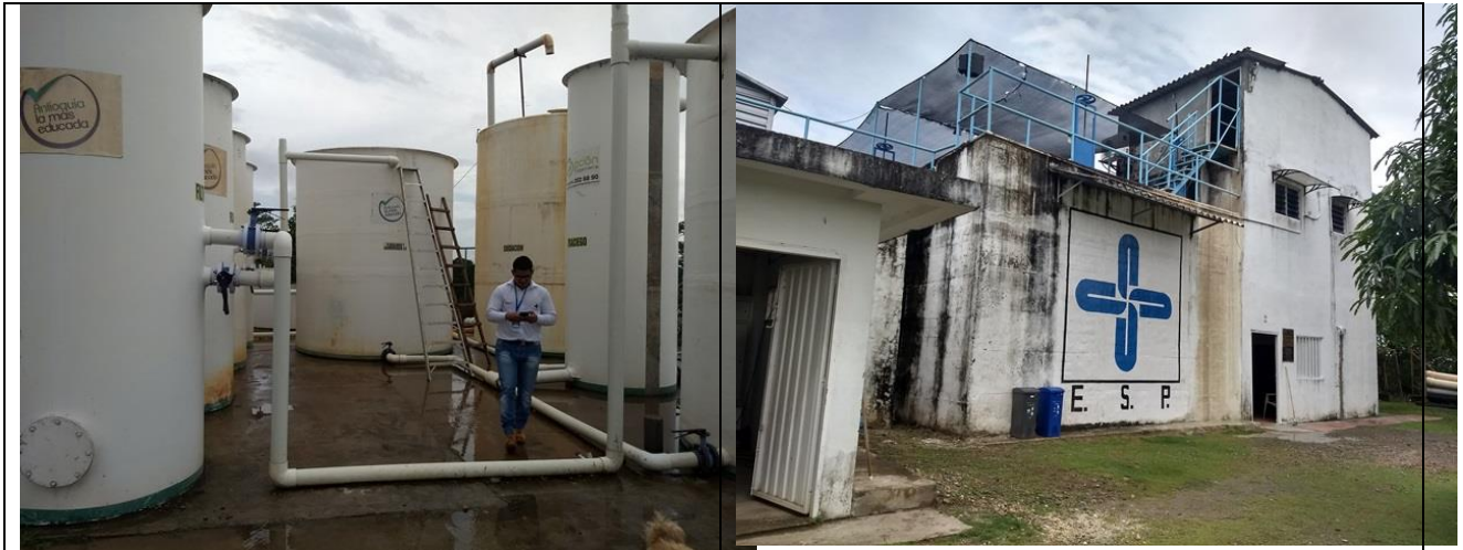
Imagen 19. PTAP compacta para el sistema veredal
