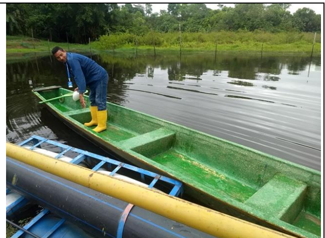
Imagen 18. Aducción tubería 8" y 10"
