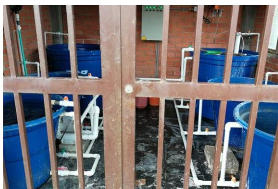
Para el tratamiento de los residuos generados en el proceso de potabilización en la PTAP se cuenta con dos unidades de lechos de secado de lodos, en las cuales se descargan los residuos líquidos y sólidos junto con los lodos decantados producto del lavado, y mantenimiento de los sistemas de tratamiento presentes en la PTAP, por medio de tuberías perforadas; estas descargas se conducen por gravedad (fuerza hidrostática), hacia los lechos de secado de lodos.
