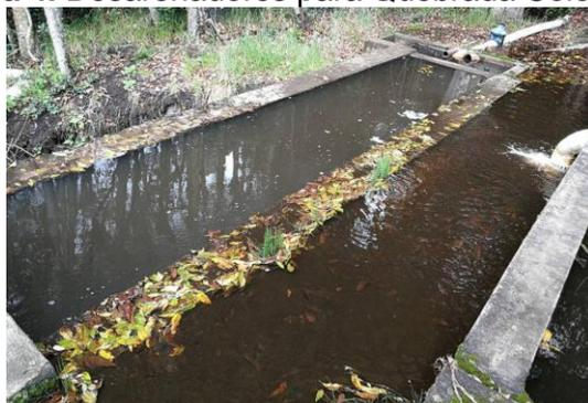
De igual forma, inmediatamente al lado del desarenador para la Quebrada Colorados, se tiene un desarenador para el Embalse Pantano de Arce, el cual se muestra a continuación:
