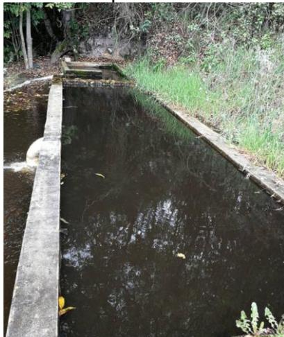
Luego de los desarenadores, el agua cruda sigue su trayectoria por las tuberías de 6 pulgadas de diámetro hasta la PTAR LLANITOS.
