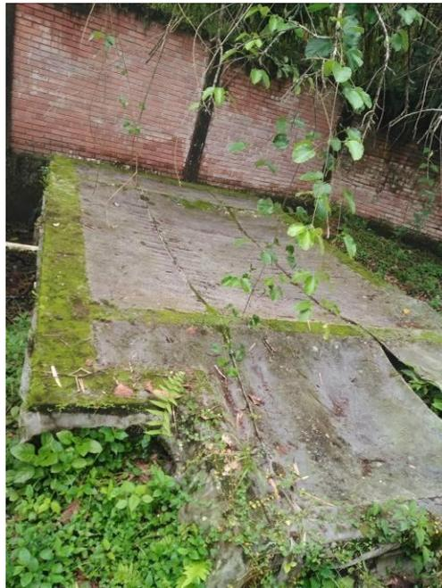
*Imagen 34. Tanque sedimentador.*
