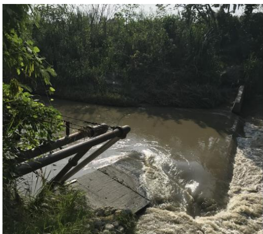
Captación en Río La Paila (Buen estado)
