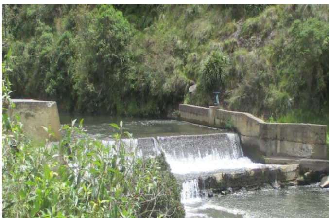
Figura 11 Bocatoma lateral
