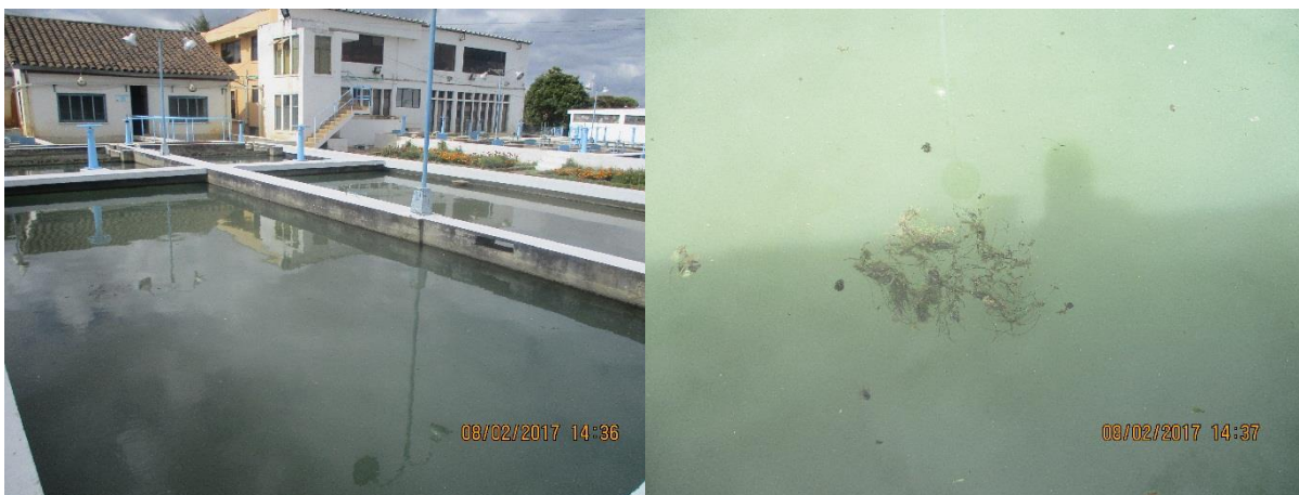
Figura 19 Sedimentadores Convencionales
