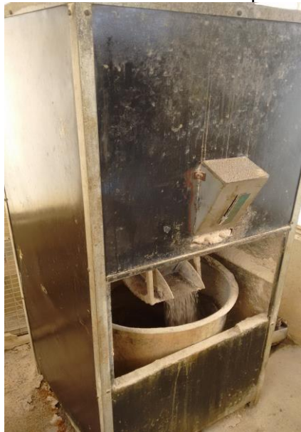
Figura 21 Dosificador del Sulfato de Aluminio para la PTAP 1 y PTAP 2
