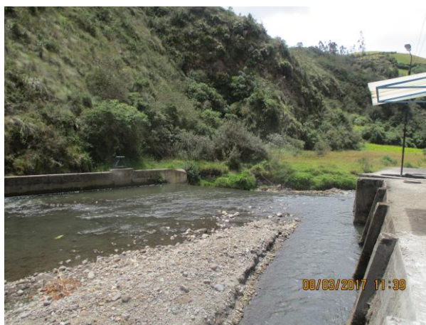
Figura 12 Efectos de la sedimentación aguas arriba de la bocatoma lateral
