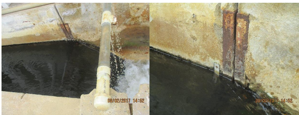
Figura 20 Vertedero de cresta ancha Planta 2
