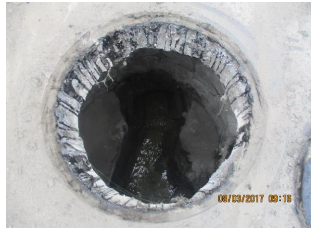
Figura 26 Pozo de inspección (calle 24 con carrera 13 esquina)
