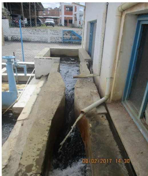
Figura 17 Canaleta Parshall
