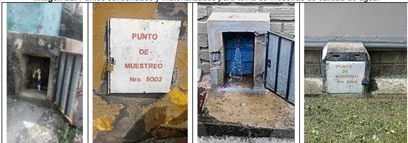
Fuente: Visita de inspección – 2018.
