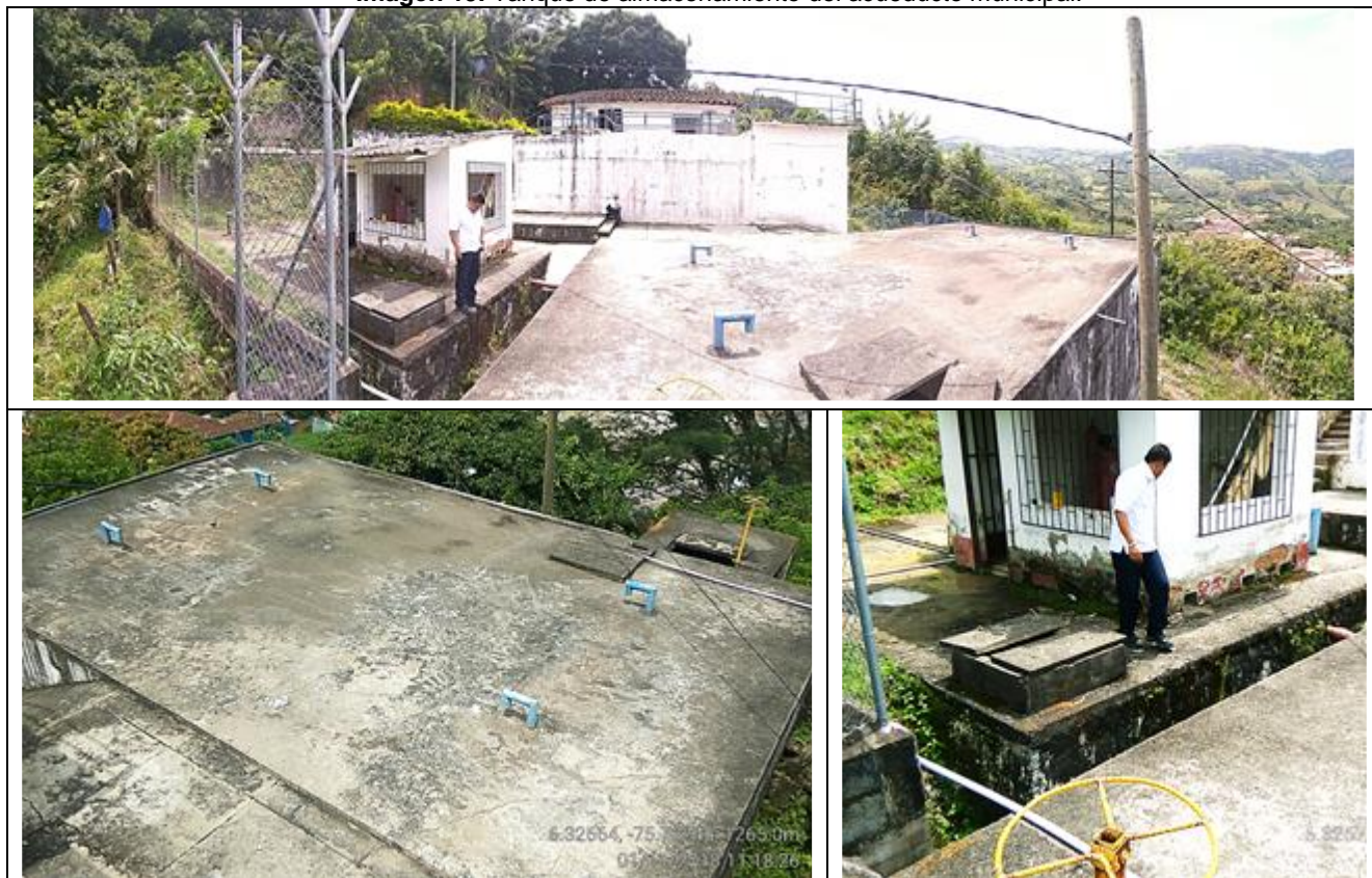
Imagen 19. Tanque de almacenamiento del acueducto municipal.
