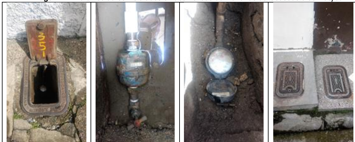
Fuente: Visita de inspección – 2018.
