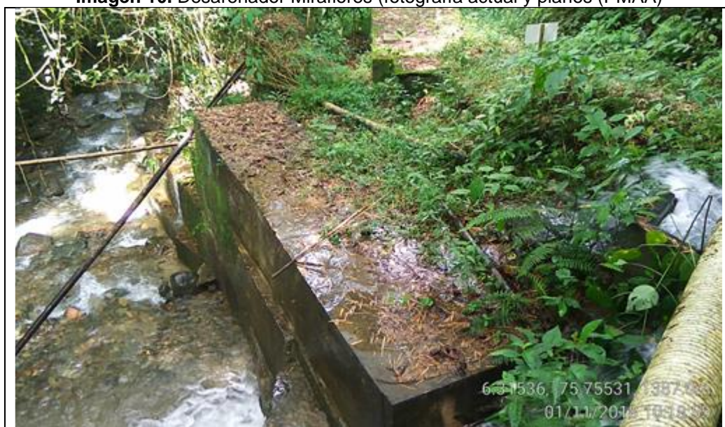
Imagen 10. Desarenador Miraflores (fotografía actual y planos (PMAA))
