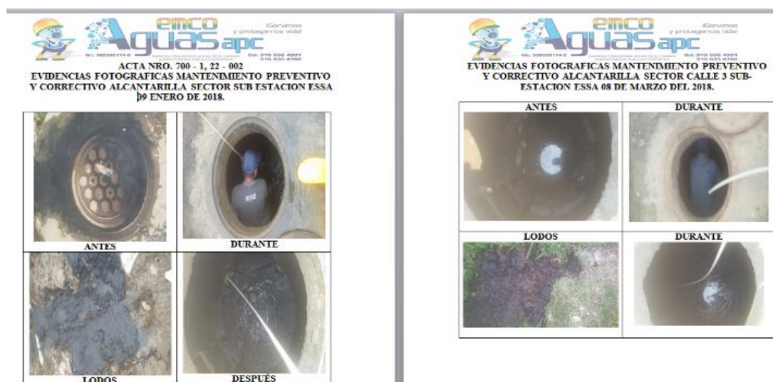
Imagen 47. Registros de mantenimiento al Sistema de Alcantarillado
