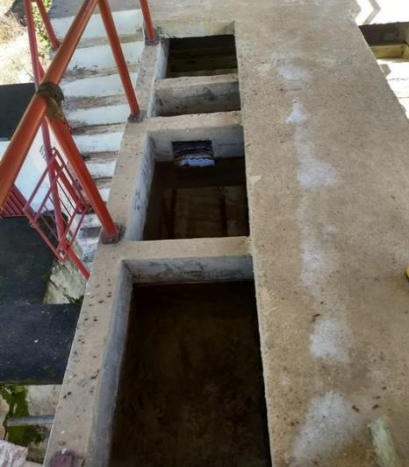
Imagen 25. Módulos de sedimentación
