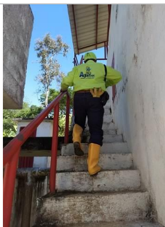
Imagen 20. Acceso a módulos de tratamiento
