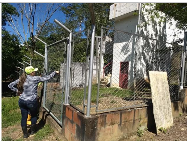
Imagen 19. Cerramiento PTAP convencional
