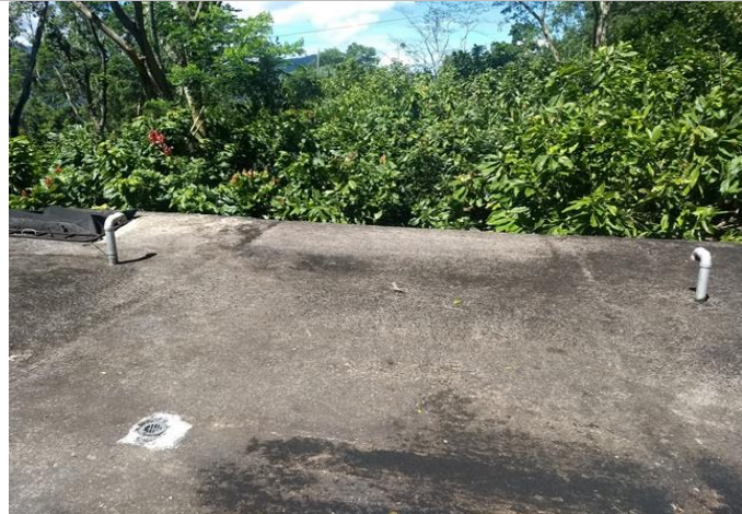
Imagen 34. Tanque de almacenamiento en primer nivel
