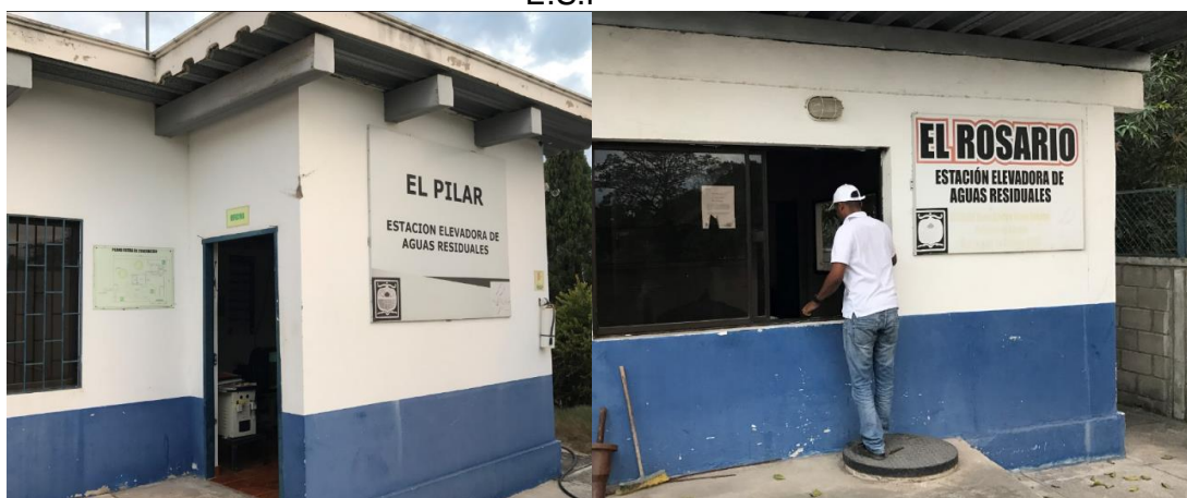
EBAR El Pilar
