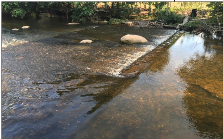
Figura 12. Presa de la Bocatoma Lateral en la Zona de Captación en el Río Ranchería
