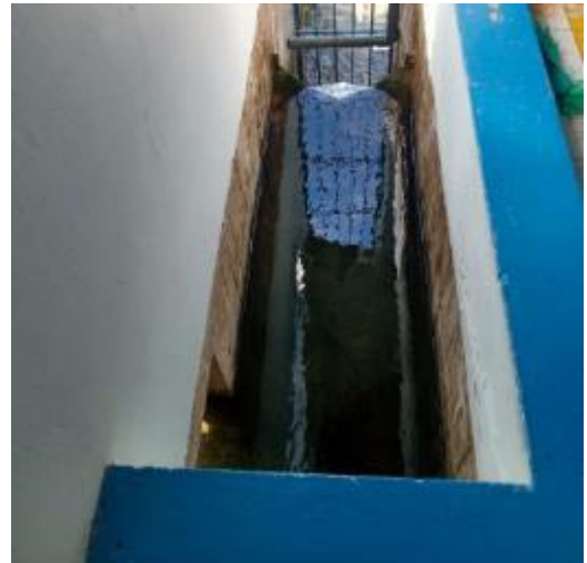
Canal de entrada
