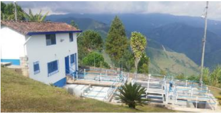
Vista general de la planta
