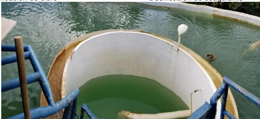
**Tanque sedimentador y filtro**
