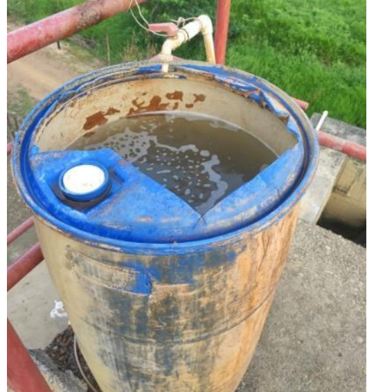
Imagen 13. Sistema alternativo de dosificación de coagulante
