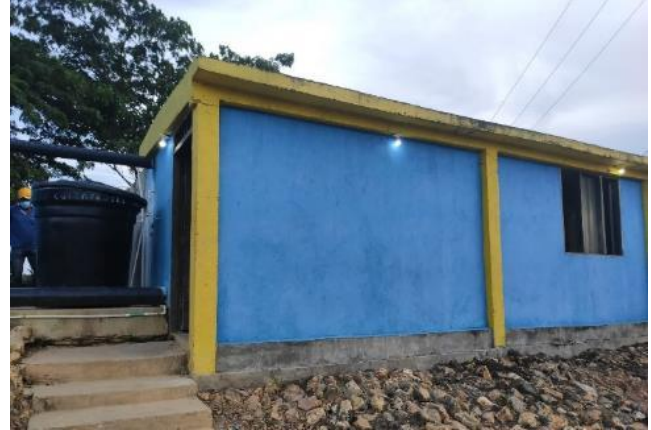
Imagen 40. Estación de bombeo a red de distribución – Zona rural
