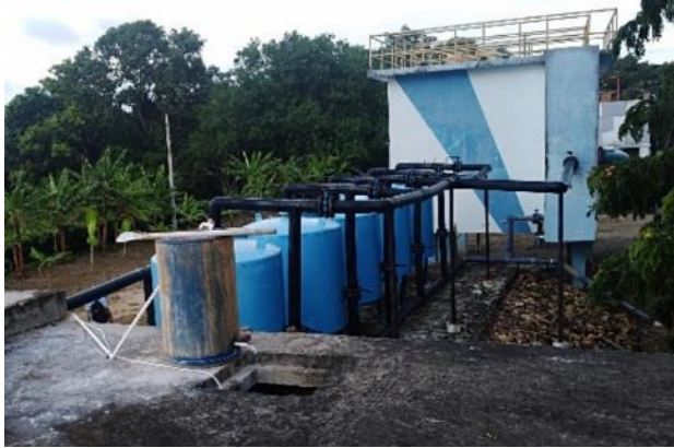
Imagen 26. Desinfección – tanque de almacenamiento
