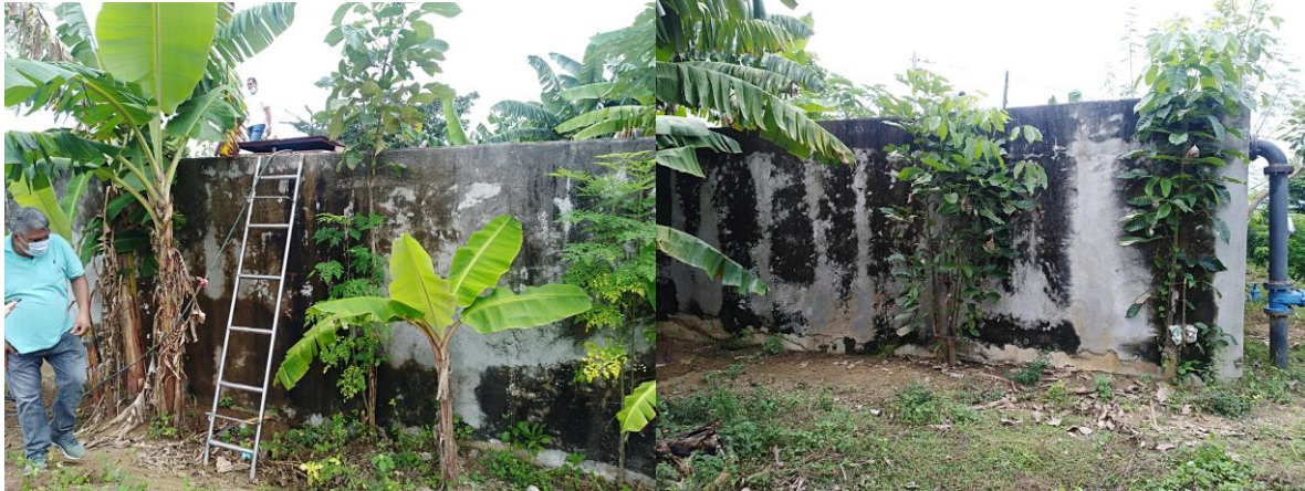
Imagen 37. Tanque de almacenamiento PTAP – Corregimiento José Manuel
