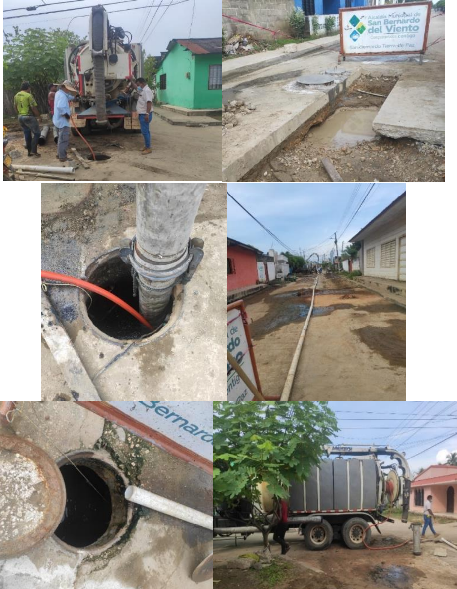
Imagen 50. Labores de mantenimiento y rehabilitación de las redes de alcantarillado
