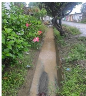
Imagen 56. Canal de recolección de aguas lluvias
