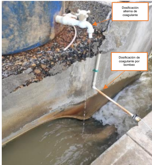
Imagen 12. Vertedero para mezcla rápida
