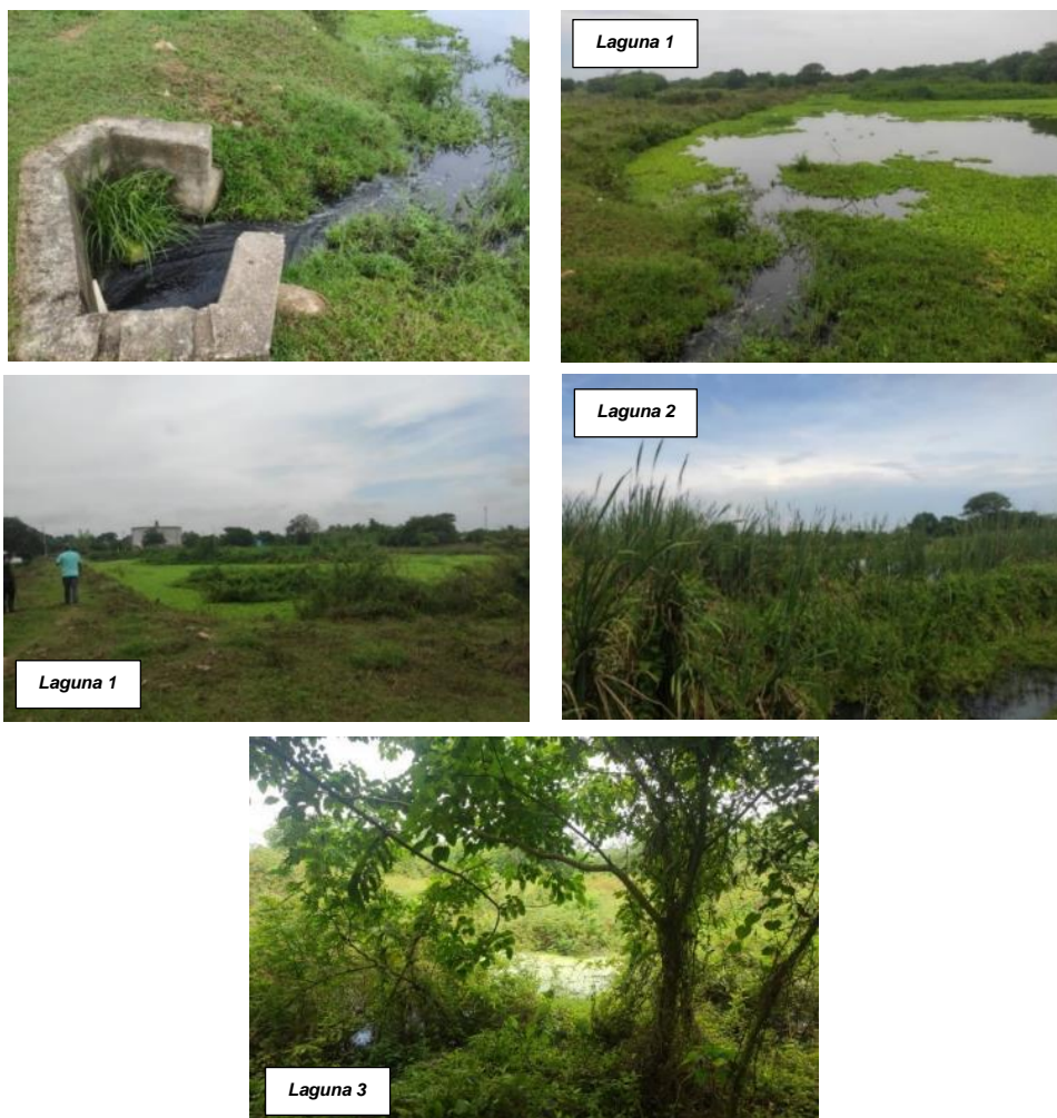
Imagen 53. Canal de ingreso y tren de lagunas de aguas residuales
