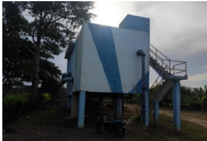
Imagen 21. PTAP zona rural
