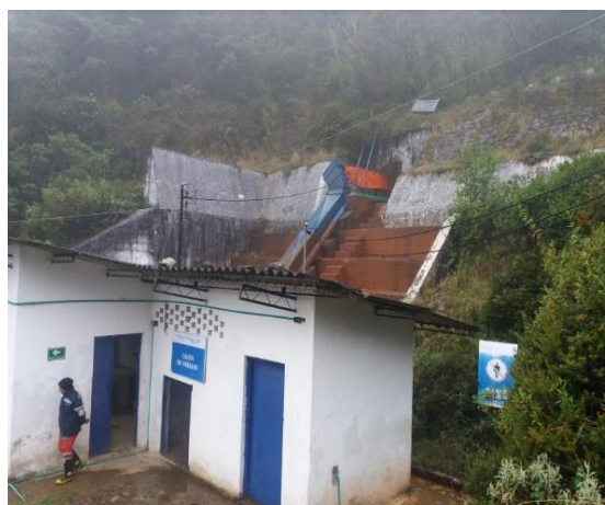
Salida de túnel de captación y caseta.
