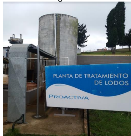
Planta de tratamiento de lodos.
