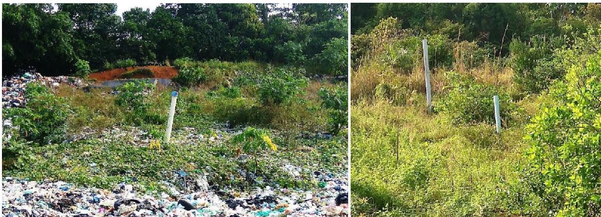
**Imágenes 98 y 99:** Se observan las chimeneas de evacuación pasiva de gases de las celdas 3 y 1.
