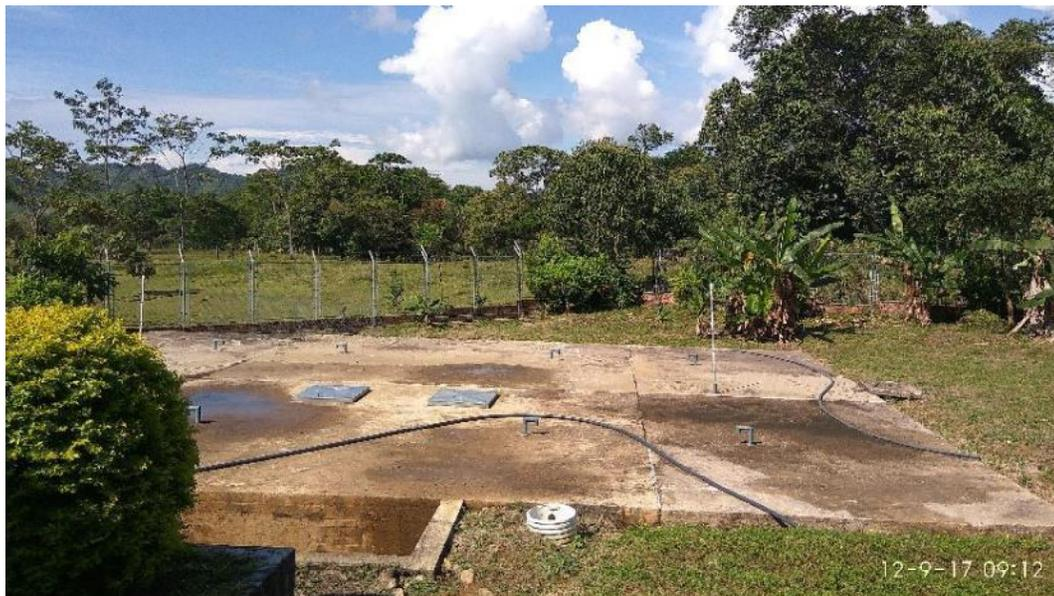
**Imagen 53:** Se observa el tanque de almacenamiento enterrado del acueducto de San José del Fragua.
