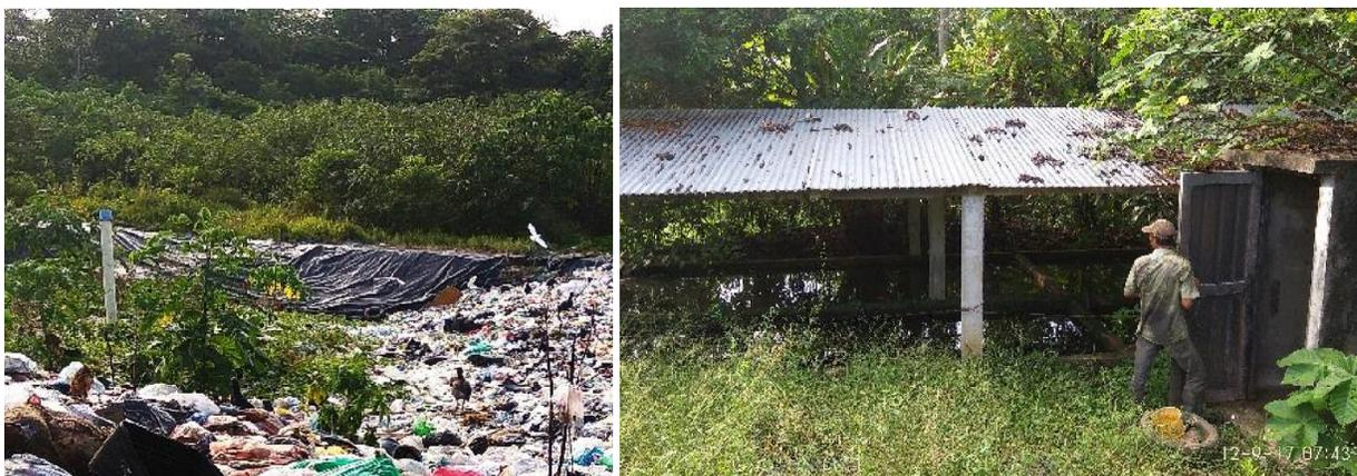
**Imágenes 91 a 94:** En la imagen superior izquierda se observa la celda 3 (en uso), donde es visible la geomembrana instalada sobre el talud lateral de la celda, y a la derecha, el tanque sedimentador que recibe los lixiviados del relleno sanitario, instalación que cuenta con cubierta para evitar el influjo de aguas lluvias. Abajo se presenta la electrobomba a través de la cual se recirculan los lixiviados, y una vista de las cámaras del tanque sedimentador de lixiviados.
