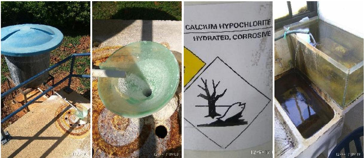
Finalmente se realiza la aplicación de desinfectante, donde se emplea cloro granulado disuelto, aunque se cuenta con infraestructura para la aplicación de cloro gaseoso, la cual salió de operación debido a un accidente laboral ocurrido en 2011.
