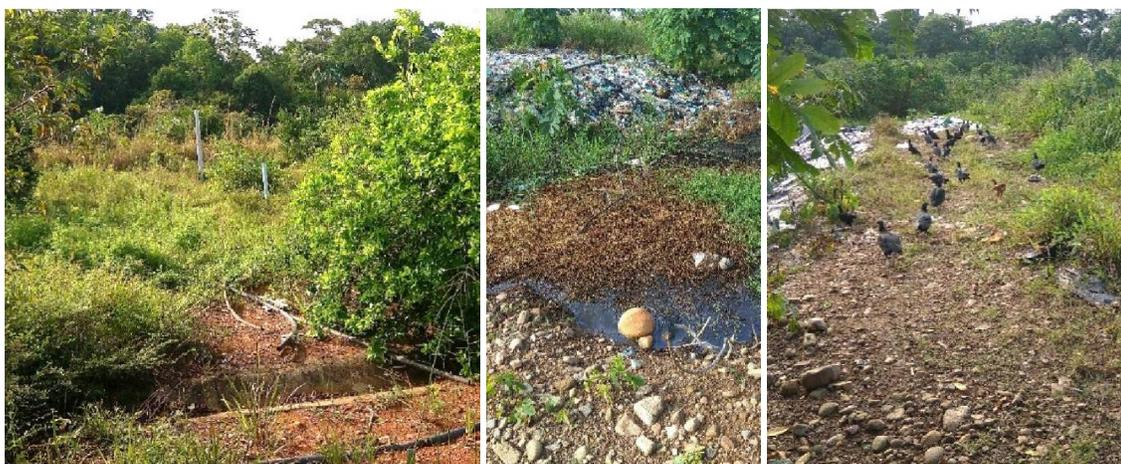
**Imágenes 95 a 97:** Se observa el estado actual de canales de evacuación de aguas lluvias alrededor de las celdas 1 y 2 (en su orden), las cuales presentan acumulación de sedimentos y crecimiento de especies vegetales; y a la derecha se observa la total ausencia de canales para el manejo de aguas lluvias alrededor de la celda No. 3.
