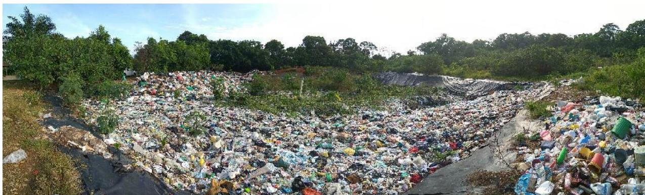
**Imágenes 86 a 90:** Se presenta el estado actual del Relleno Sanitario El Cairo, donde se denota ausencia de las medidas mínimas de manejo del sitio, evidenciadas en la forma en que se dispersan los residuos en la celda, omisión de la conformación de terrazas, compactación y manejo de celda diaria, y absoluta ausencia de cobertura de los residuos.
