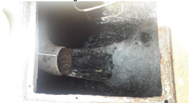
a) anque de almacenamiento.
