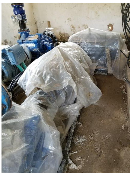
Instalación de bombas nuevas plan de choque
