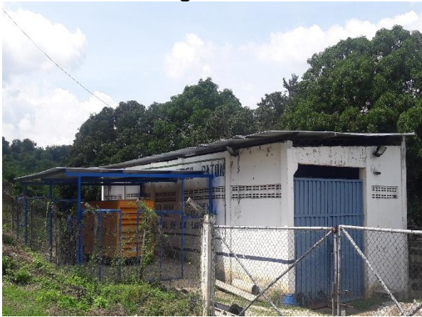
Imagen 13. Estación de bombeo de agua potable Patón.
