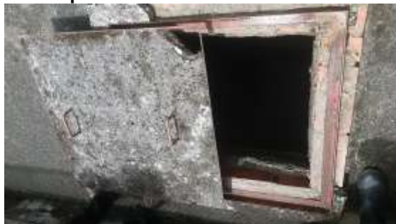
Imagen 36 Tanque de almacenamiento Las Mercedes
