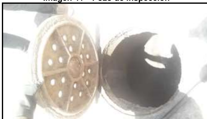
Imagen 41 Pozo de inspección
