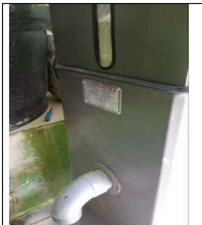
Fotografía No. 12 Dosificador sulfato de aluminio
