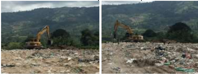
Ilustración 20: Maquinaria en Operación
