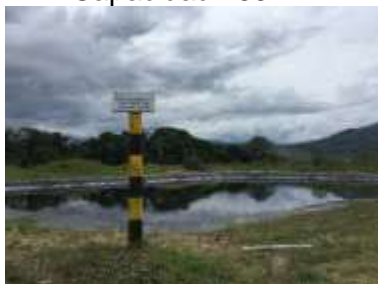
Ilustración 35: Piscina de lixiviados provenientes del sitio de disposición final. Capacidad 1861m 3
