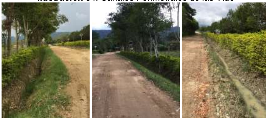
Ilustración 34: Canales Perimetrales de las Vías
