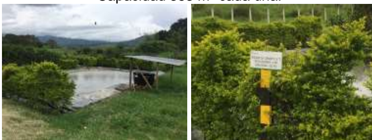
Ilustración 36: Piscinas de lixiviados provenientes del área de compostaje. Capacidad 353 m 3 cada una.
