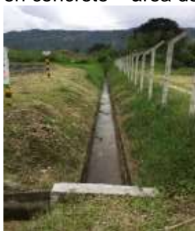
Ilustración 34: Canales Perimetrales de las Vías
