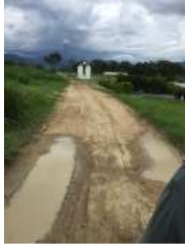
Acceso a Tratamiento de Lixiviados
