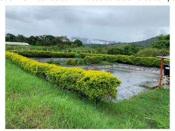
Ilustración 25. Piscinas de Lixiviados del sistema de compostaje
