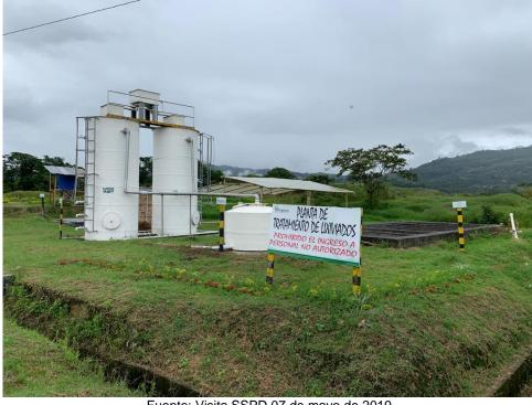
Ilustración 26. Planta de tratamiento de lixiviados
