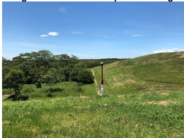
Imagen 58. Chimenea de quema de biogás
