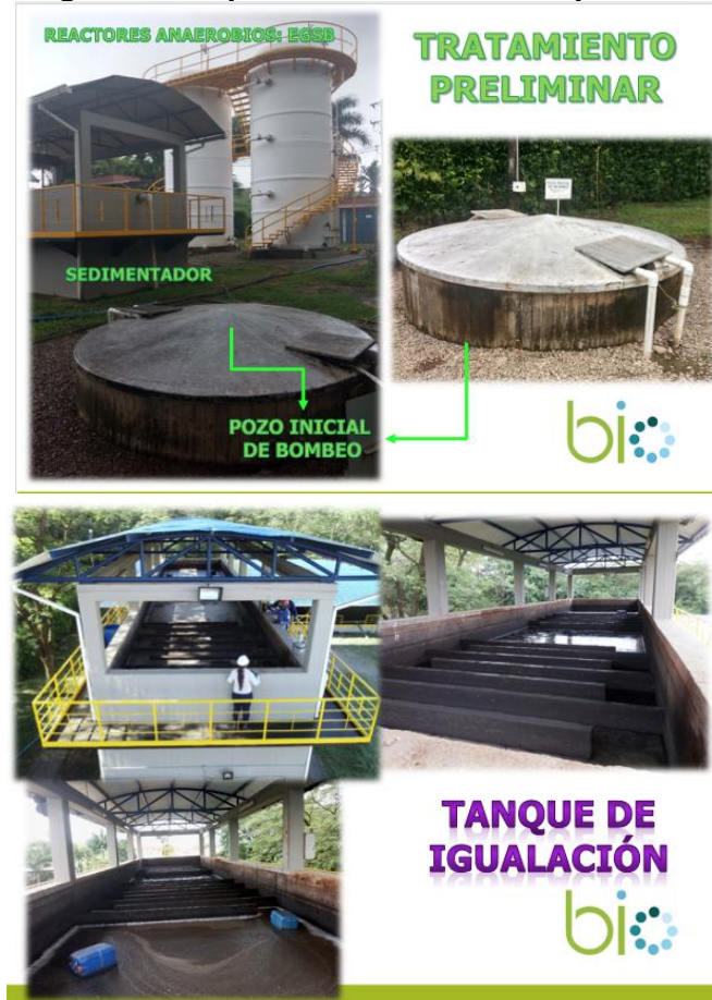
Imagen 50. Esquema del Tratamiento preliminar
