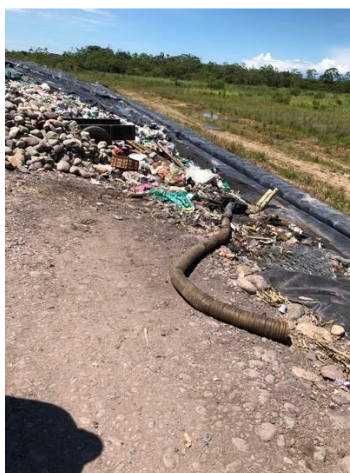
Imagen 49. Tuberías de conducción de lixiviados provenientes de los compactadores
