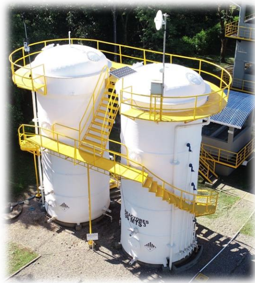
Imagen 53. Vista aérea de zona de tratamiento secundario
