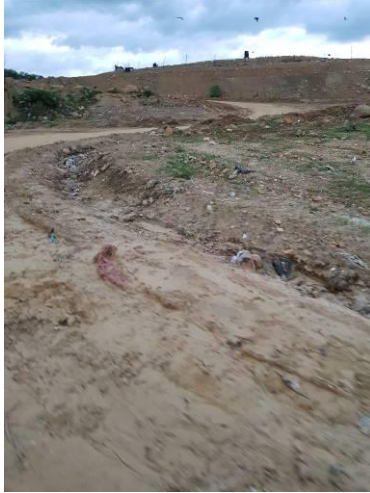
Ilustración 107. Cuneta perfilada en material térreo al costado de la vía temporal. Fuente
