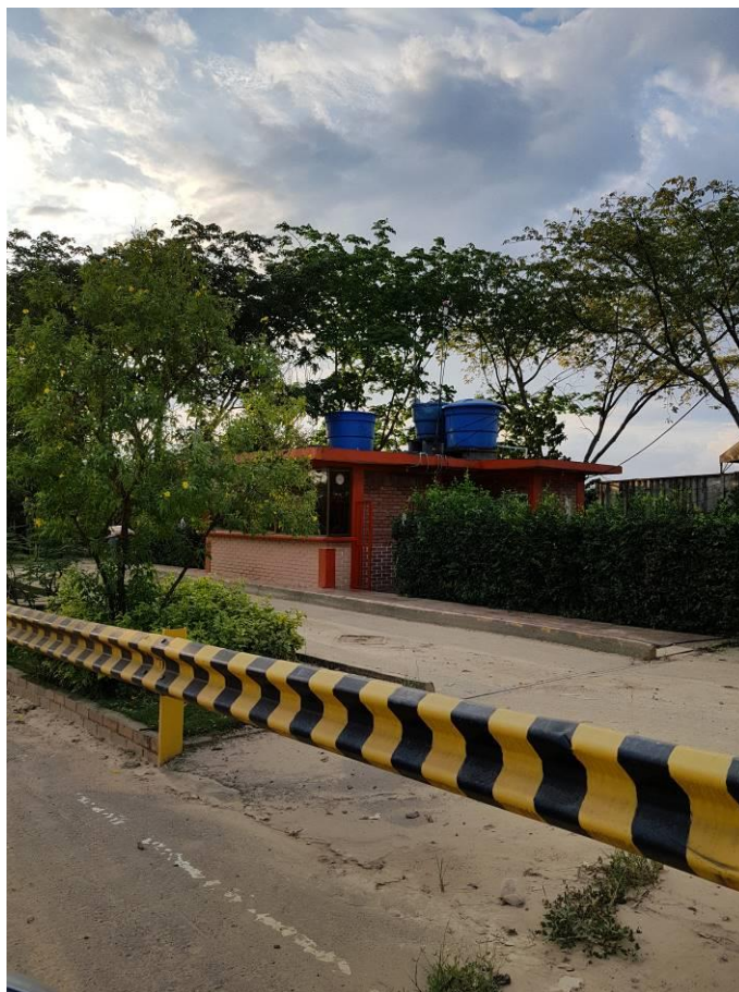
Ilustración 90. Módulo para el pesaje de vehículos.
