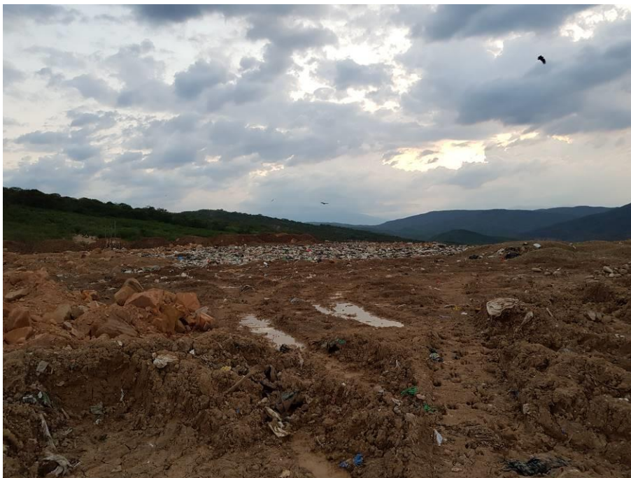
Ilustración 97. Áreas de residuos descubiertos en frente de trabajo anterior.
