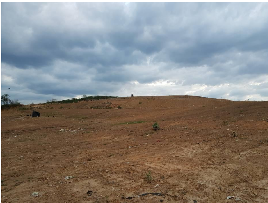
Ilustración 98. Zonas parcialmente clausuradas cobertura en arcilla.
