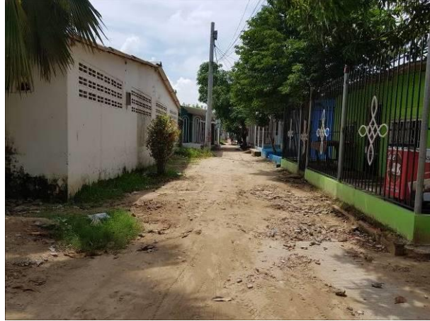
Ilustración 8. Tramos viales de calzadas reducidas. Fuente: Visita de inspección y vigilancia del 21 y 22 de septiembre de 2017
