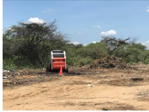
Foto 14. Uso de Minicargador BOBCAT S175 para recuperación de puntos críticos
