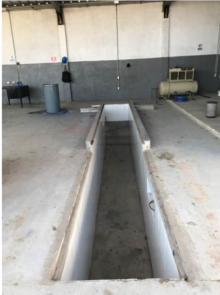
Foto 19. Área de mantenimiento de vehículos
