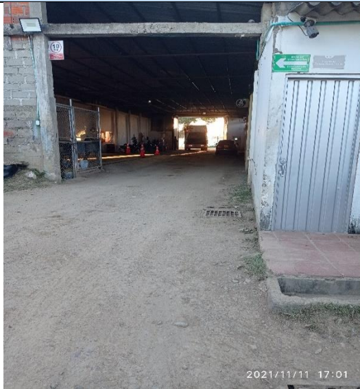
Portón de acceso a los vehículos
