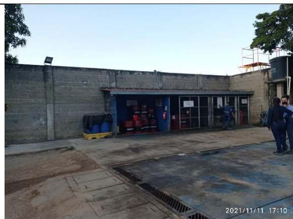
Taller de mantenimiento
