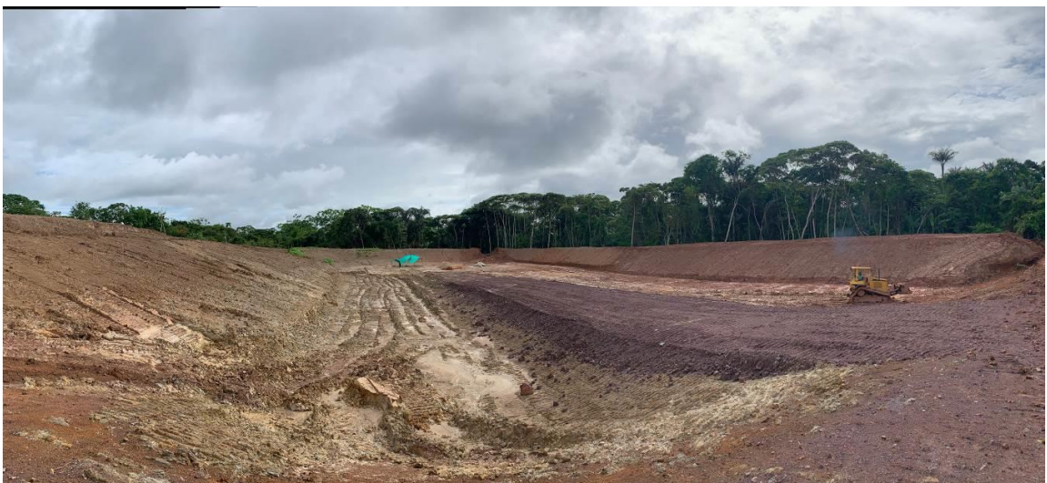
Imagen 21. Celda en adecuación
