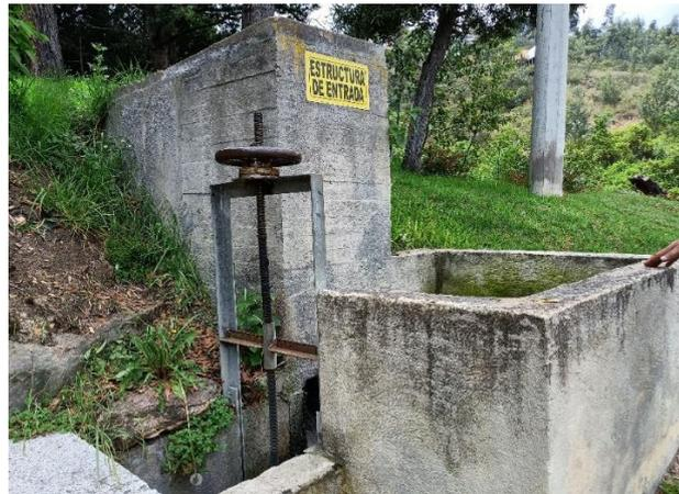
*Imagen 4. Tuberías de llegada sistema de alcantarillado y estructura hidráulica de alivio de aguas lluvias*
