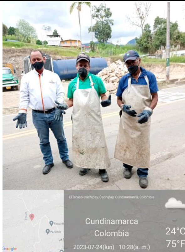
Imagen 21. Porte de elementos de protección personal de operarios y conductor vehículo con placa OFK747
