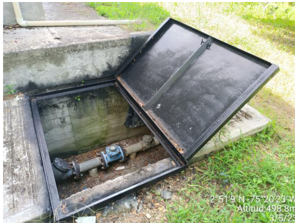
Cajilla para los macromedidores a la salida de los tanques de almacenamiento.
