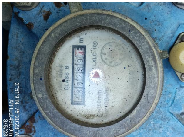
Macromedidores a la salida de los tanques de almacenamiento de la PTAP.
