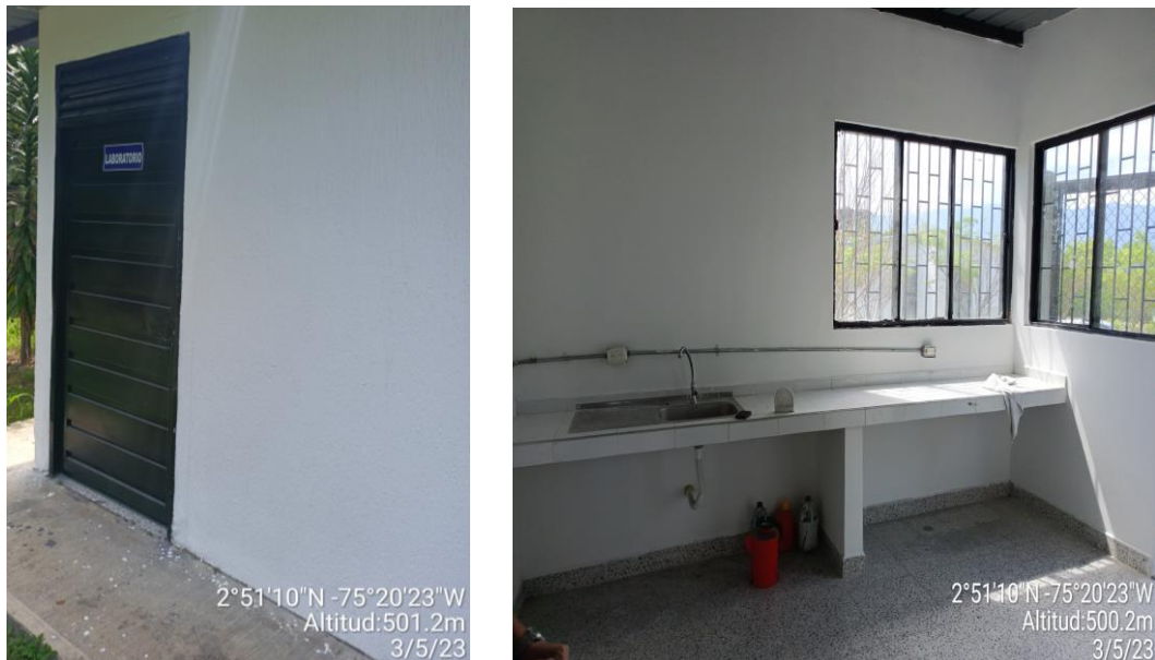
Imagen 19. Vista externa e interna laboratorio de control de calidad del agua en la PTAP Llanos de Vimianzo Club House.
