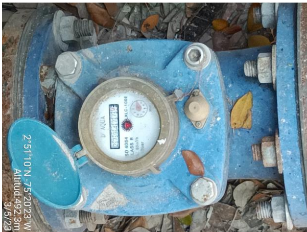
Macromedidores a la salida de los tanques de almacenamiento de la PTAP.
