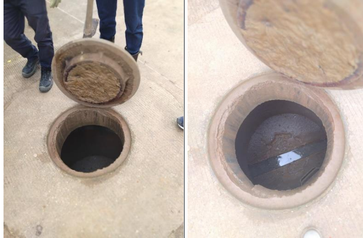
Imagen 11. Pozos de inspección
