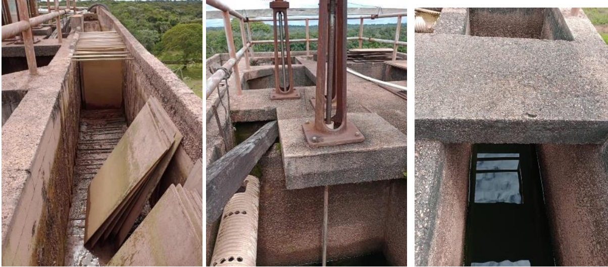
Imagen 7. Estado actual PTAP
