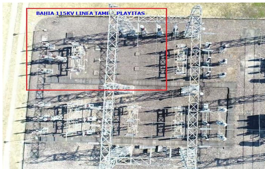
Figura 40. Disposición física subestación Tame 115 kV
