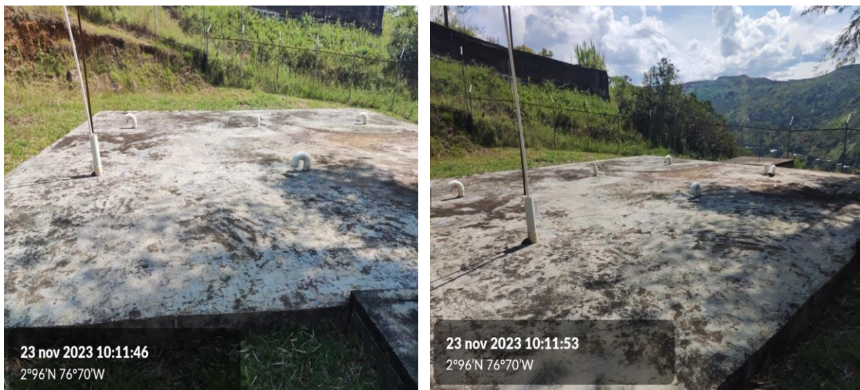
Imagen 9. Tanques de almacenamiento
