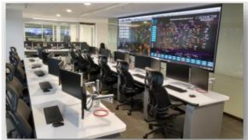
Figura 36. Centro de operaciones MT/BT
