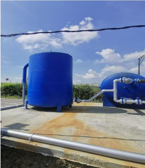
Sistema de aireación de burbuja a presión
