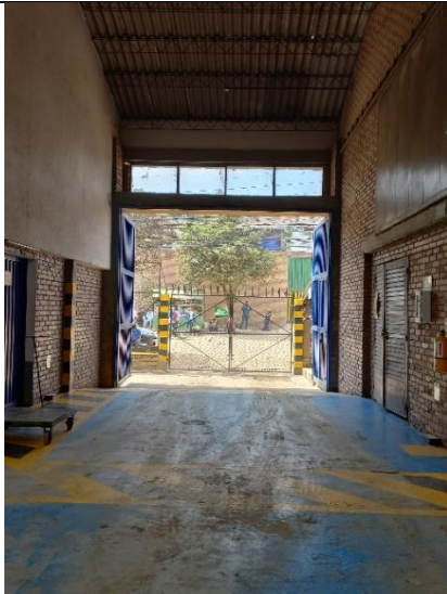
Imagen 68 Control de ingreso, portería y puerta
