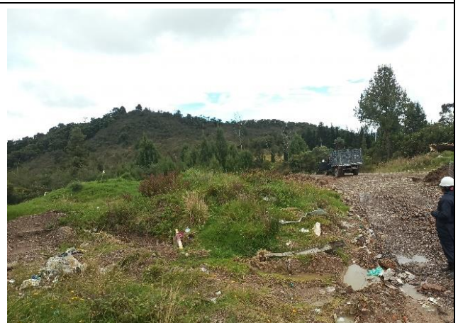
Imagen 59 Vía interna del relleno (Empozamientos de agua lluvia)
