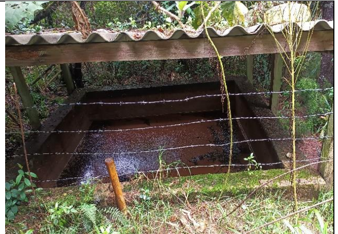
Imagen 63 Tanque de lixiviados
