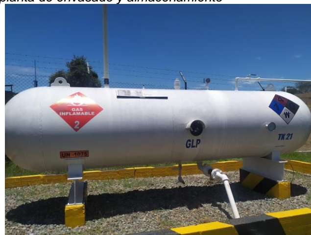
Imagen 2. Tanques estacionarios de la planta de envasado y almacenamiento
