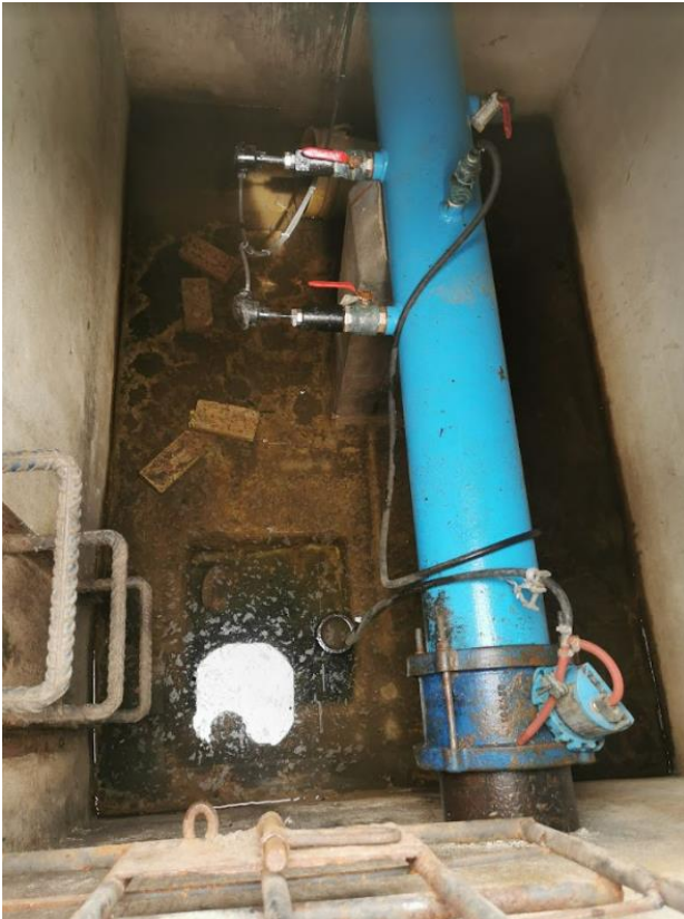
Imagen 7. Medición de caudales suministrados
