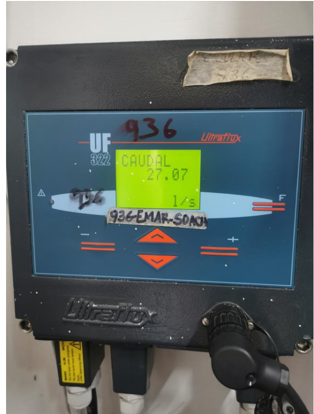
Imagen 7. Medición de caudales suministrados
