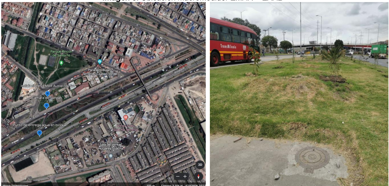
Imagen 5. Ubicación macromedidor EMAR – EAAB
