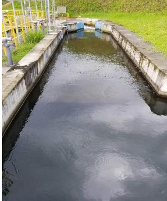
Canal de entrada a la planta
