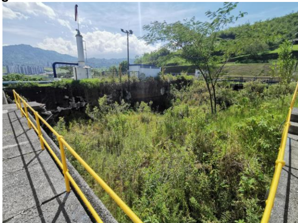
Imagen 12. Planta de tratamiento Aurora Fuera de servicio.
