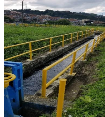
Caudal entregado a Serviciudad
