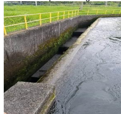
Canal de excesos
