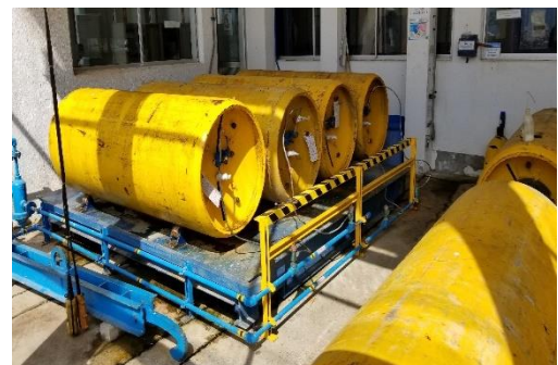
Tanques de cloro gaseoso
