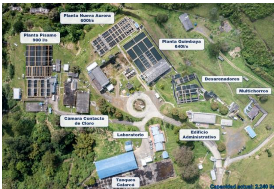
Imagen 9. Ubicación Plantas de tratamiento de Agua Potable
