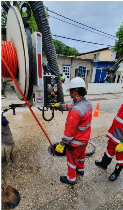
Ejecución de mantenimiento preventivo
