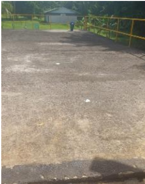
Tanque de almacenamiento agua tratada
