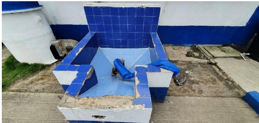
Punto de descarga de equipos succión presión
