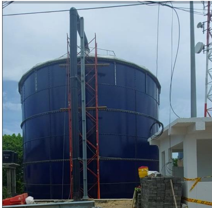
Avances Construcción Tanque La Loma Fuente: Registro fotográfico SSPD
