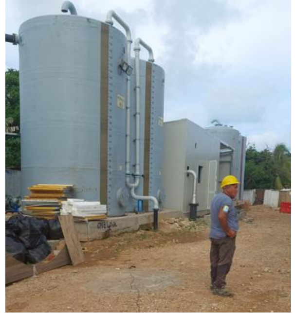
Imagen 24. Avances nueva planta desalinizadora de 50 l/s
