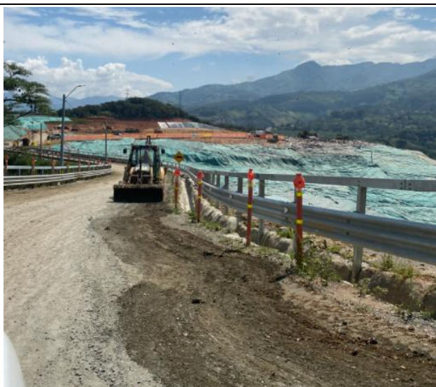
Tramo final que conduce al frente de trabajo canales perimetrales
