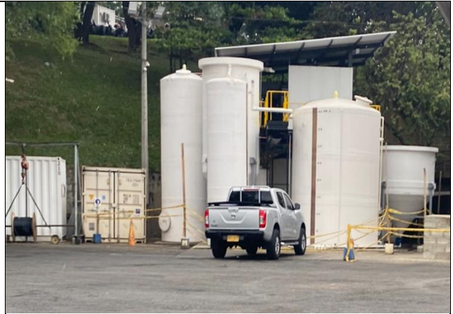
Planta de tratamiento de vertimientos en construcción
