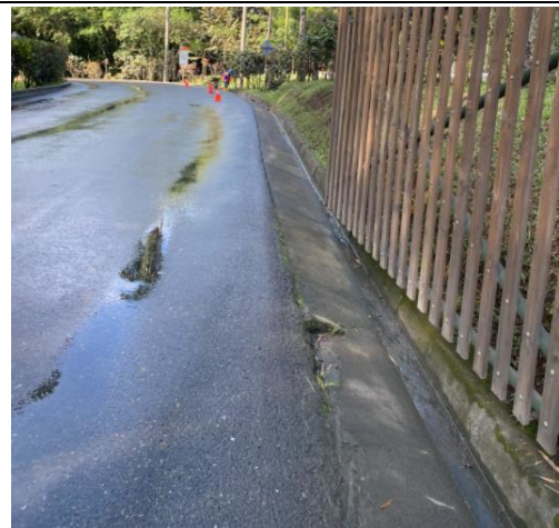
Vías internas, canales perimetrales
