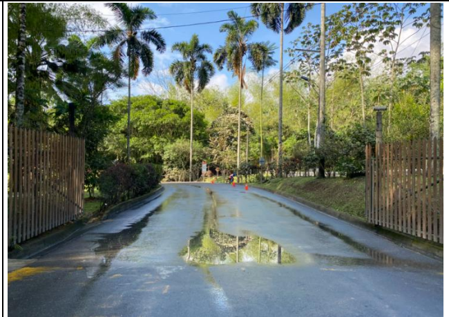
Vías externas tramo pavimentado
