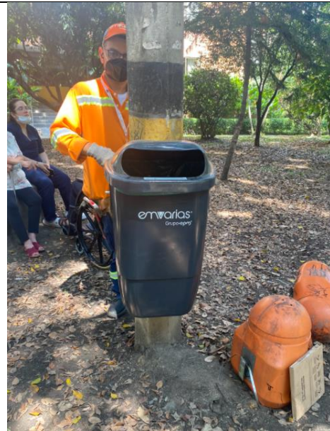
Instalación de cesta nueva
