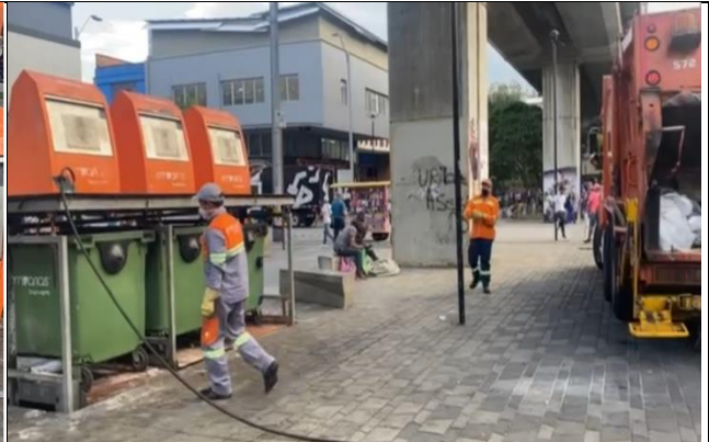
Levante de soterrados para extracción de cajas
