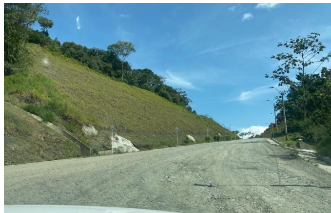
Vías internas en afirmado
